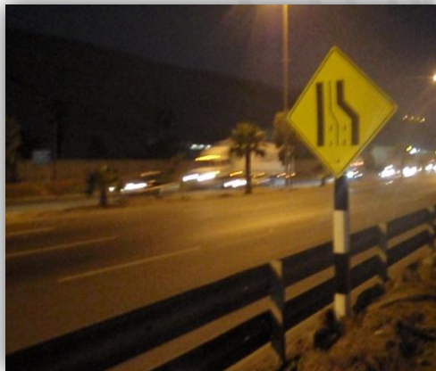
Foto 139: Señal preventiva de reducción de carril ubicada antes del Acceso 4.
