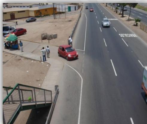
Foto 117: Vista de Acceso 5.
