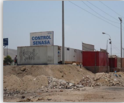
Foto 44: Estructura inestable de puestos de control.
