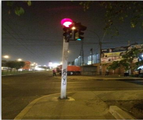
Foto 31: Semáforo interrumpe paso peatonal.
