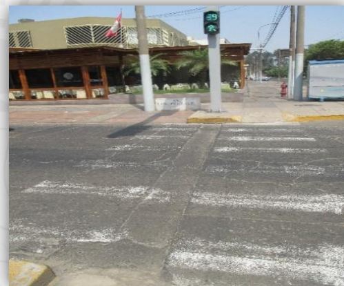
Foto 16: Cruce peatonal interrumpido por semáforo.
