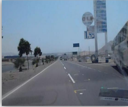
Foto 73: Panel del grifo muy cerca de la calzada y bases del mismo de concreto armado sin protección.
