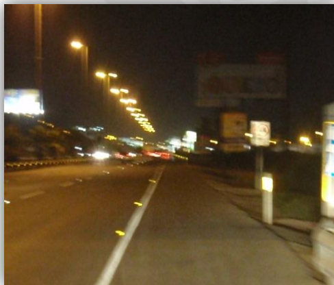
Foto 141: Buena iluminación de vía durante la noche.
