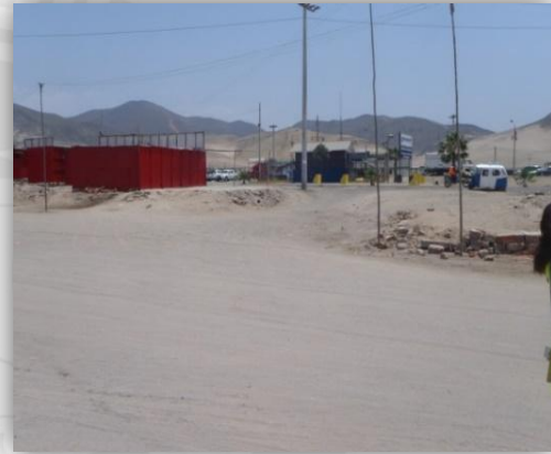
Foto 58: Acceso sin señalización y postes ubicados en zonas potencialmente peligrosas.
