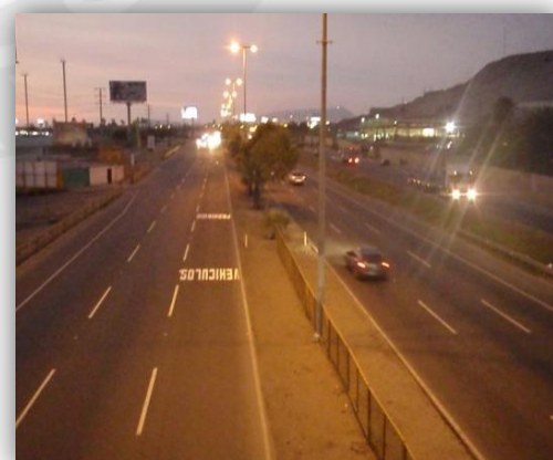
Foto 142: Demarcaciones de vía en buen estado.
