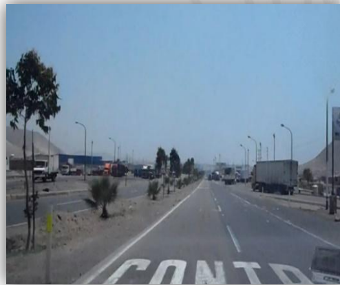
Foto 63: No existe señalización vertical de acercamiento hacia control.
