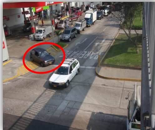
Foto 79: Conflicto entre vehículos por la mala ubicación de la salida del grifo.
