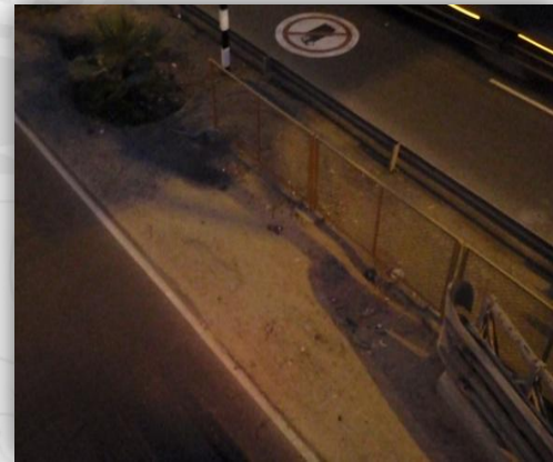
Foto 134: Vallas peatonales para obligar al peatón a cruzar la calzada por el puente.
