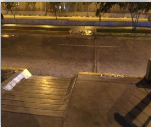
Foto 111: Rampas para discapacitados en buen estado.
