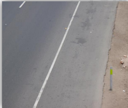
Foto 127: Ancho de berma similar al del carril permite estacionar a los vehículos en caso de emergencia.
