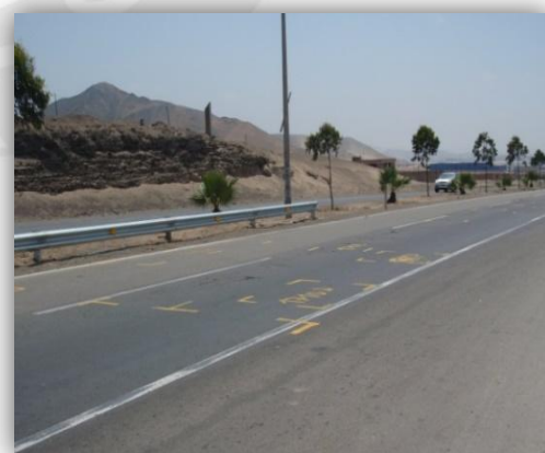
Foto 42: Poste de alumbrado en la mediana.
