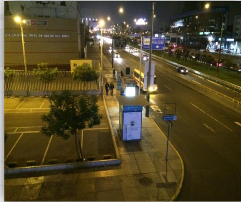
Foto 104: Buena iluminación de la vía principal de la intersección.
