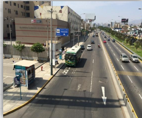
Foto 86: Calzada en la auxiliar de la Av. Avenida Javier Prado con demarcaciones desgastadas.
