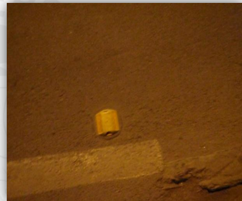
Foto 140: Tachas al borde de la berma en buen estado.
