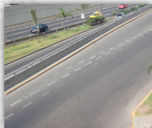
Foto 92: Demarcaciones antiguas y nuevas sobre la calzada.
