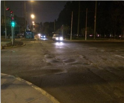
Foto 27: Escasa iluminación en zona de berma central.
