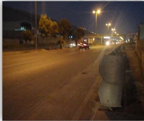
Foto 133: Guardavía con terminación para disminuir la severidad de lesiones ante un impacto.
