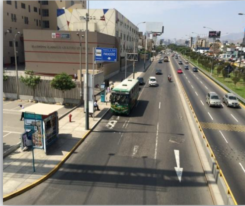
Foto 101: Postes rígidos de alumbrado público al borde de la calzada y sin protección alguna.
