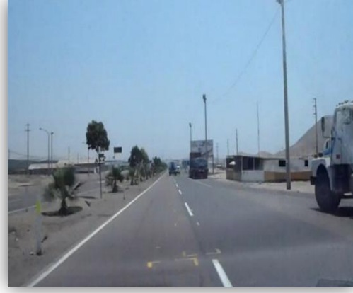
Foto 74: Poste muy cerca de la calzada y sin protección.
