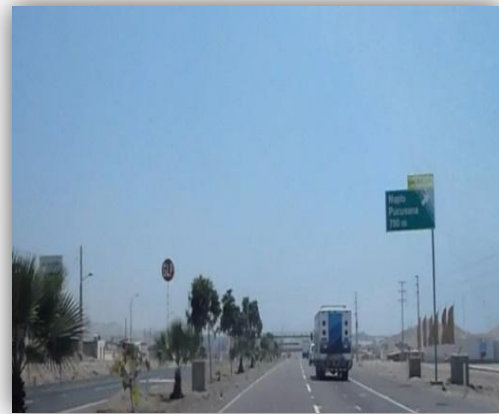
Foto 68: Elementos de concreto junto a la calzada sin protección alguna.
