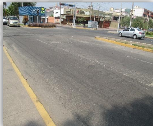
Foto 12: Falta de señalización horizontal en calzada (zona La Molina).
