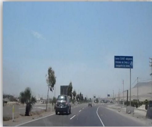
Foto 75: Base de concreto de señal de orientación cerca a la calzada y sin protección.
