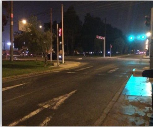
Foto 19: Rampa peatonal interrumpida por semáforos (zona La Molina).
