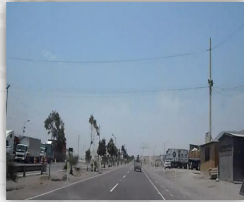
Foto 76: Casetas de la SUNAT desprotegidas y cerca de la calzada.
