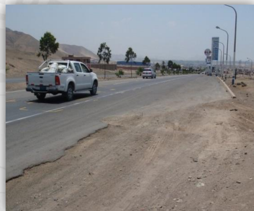
Foto 40: Calzada sin límite definido en sus bordes.
