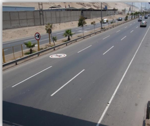
Foto 129: Demarcaciones en el pavimento en buenas condiciones. Señal de circulación de V. Pesados en carril derecho.
