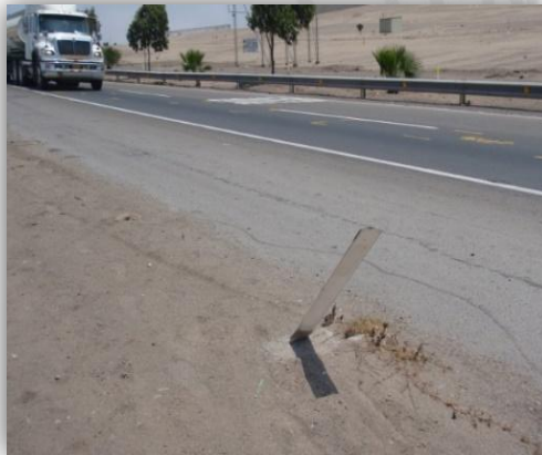
Foto 57: Delineador en malas condiciones.
