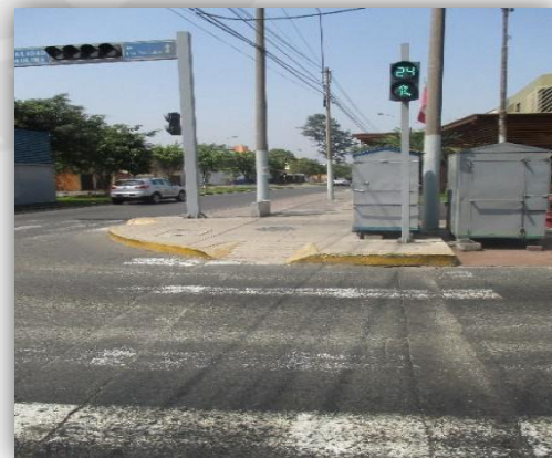
Foto 18: Cruce peatonal es interrumpido por semáforo peatonal y quioscos.
