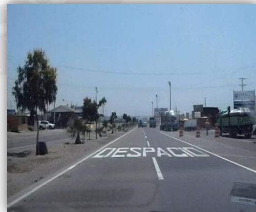
Foto 66: No hay diferenciación entre zona de control y autopista.
