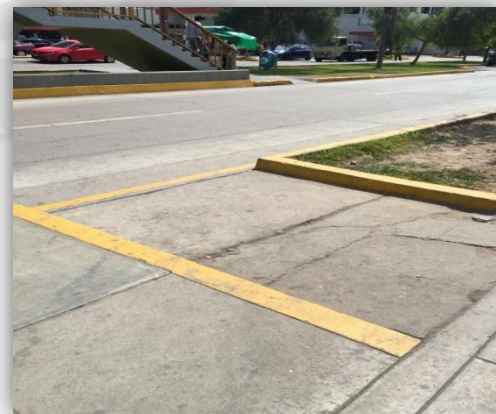
Foto 88: Rampa para discapacitados inadecuada y mal ubicada.
