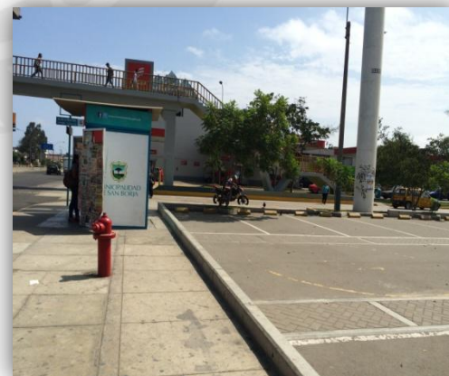
Foto 100: Quiosco ubicado en la vereda (esquina del Hospital) dificulta el tránsito libre de personas discapacitadas.
