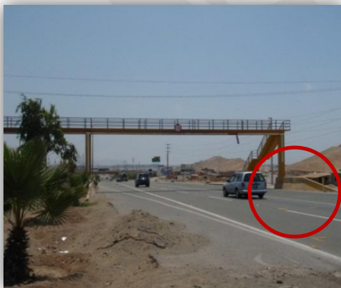
Foto 47: Elemento rígido en la base del puente.
