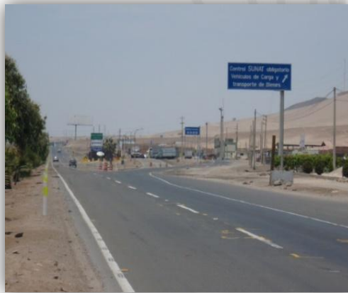
Foto 51: Elementos rígidos de señalización de apertura de vía.
