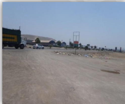
Foto 59: Acceso no señalizado.
