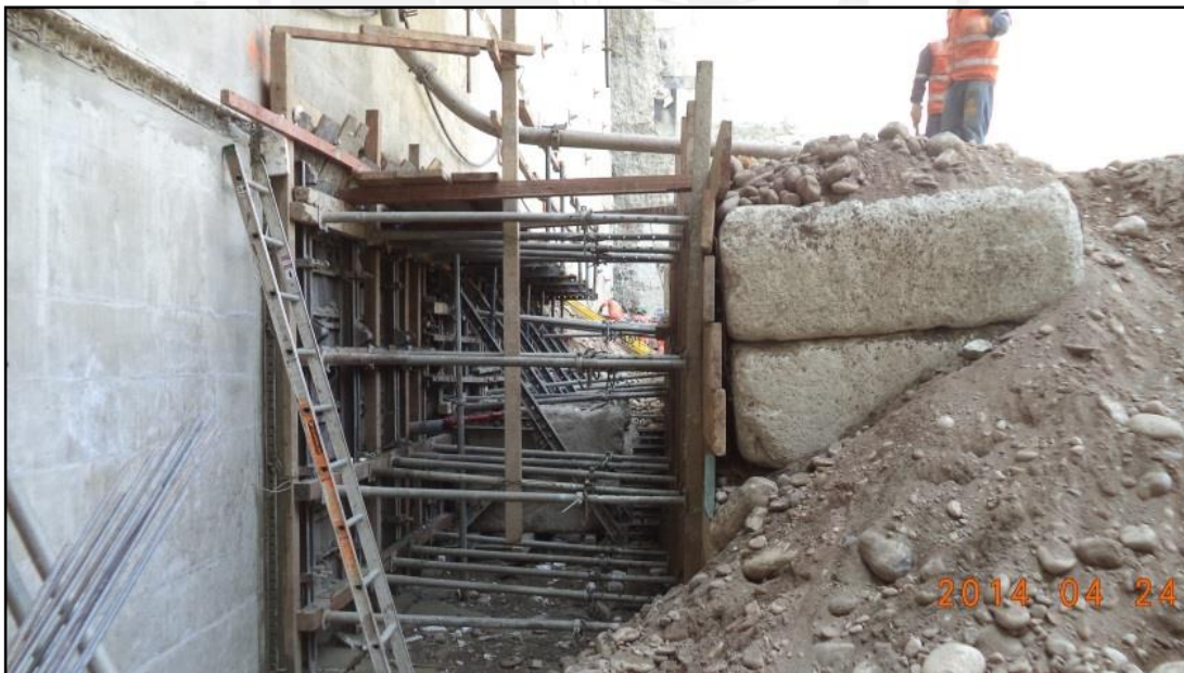
Fig. 4.9. Refuerzos de los paneles de encofrado usados en el proyecto. (Fuente: Propia)
