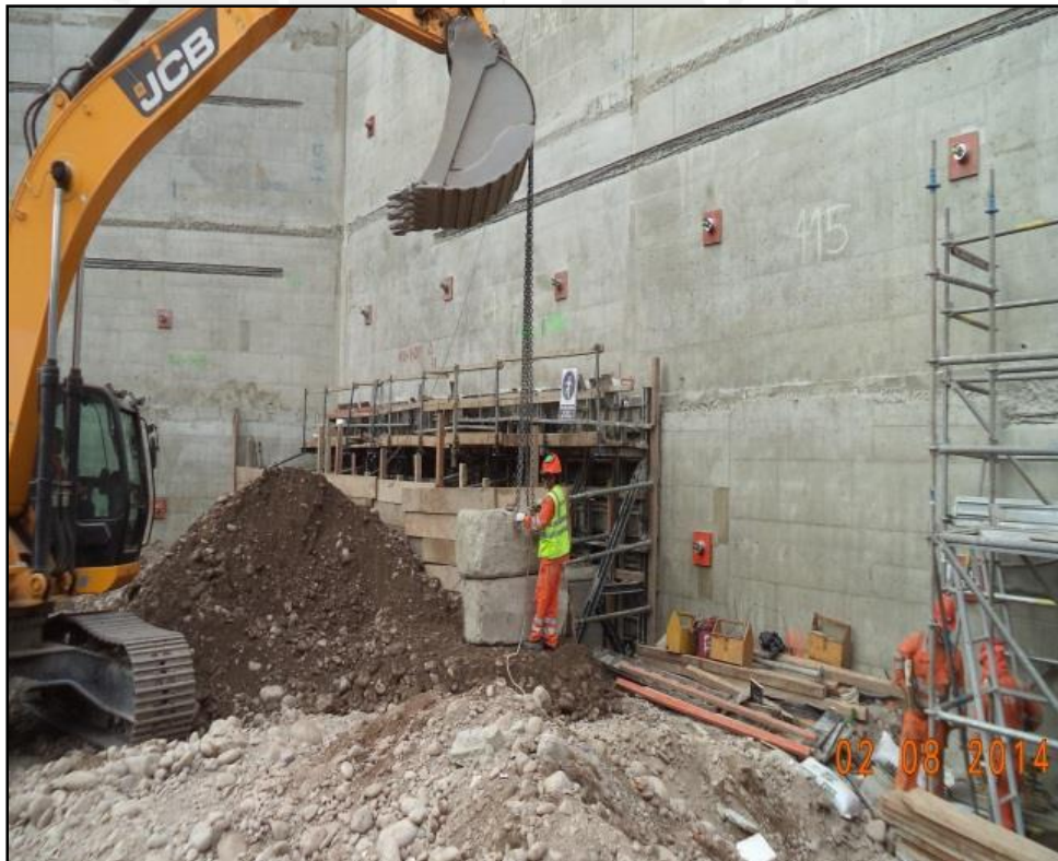
Fig. 3.11. Desencofrado usando cargador. (Fuente: Propia)
