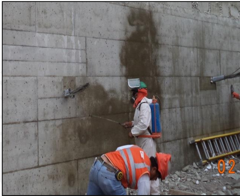
Fig. 3.12. Curado de muros. (Fuente: Propia)
