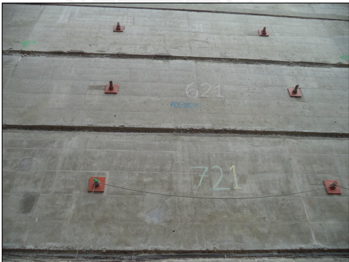
Fig. 6.7. Acabado uniforme de los muros. (Fuente: Propia)
