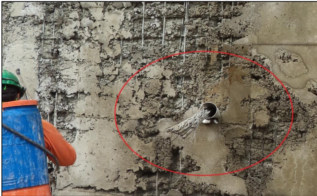
Fig. 4.2. Cangrejera en zona de anclaje. (Fuente: Propia)
