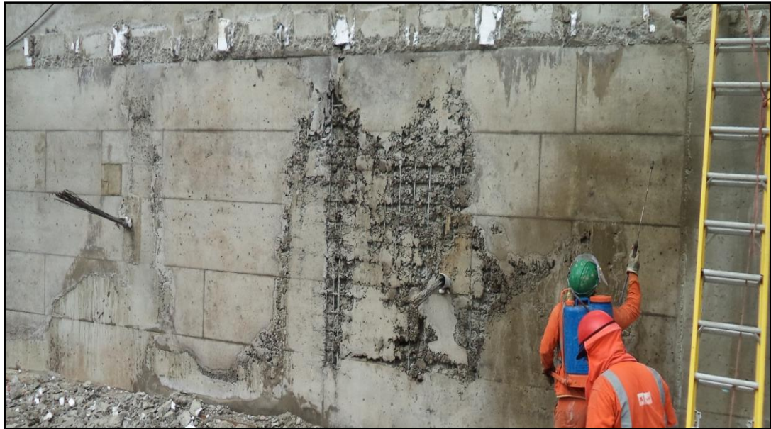
Fig. 4.1. Cangrejera en muros anclados.
