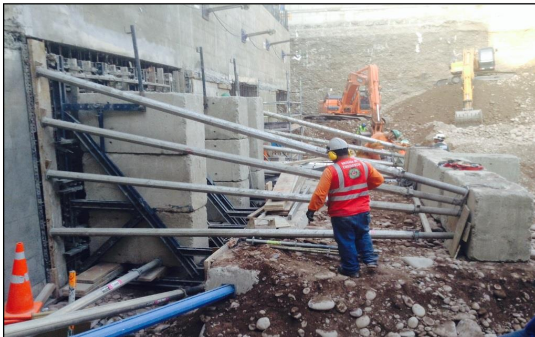
Fig. 5.5. Refuerzo tradicional utilizado en el encofrado de los muros. Proyecto “Rivera Navarrete” (Fuente: Propia)
