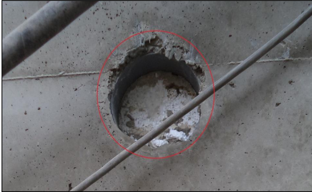
Fig. 3.14. Espacio dejado para una posterior inyección. (Fuente: Propia)
