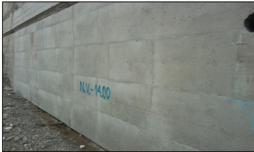
Fig. 6.6. Cara uniforme de los muros pantalla. (Fuente: Propia)
