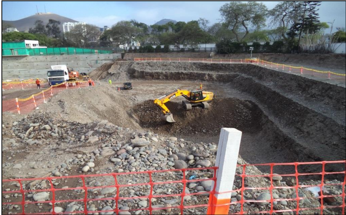
Fig. 3.8. Excavación masiva Proyecto Panorama. (Fuente: Propia)
