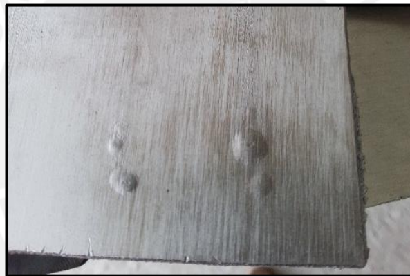
Figura 3.5 Lado opuesto donde se aprecia que no hubo penetración
