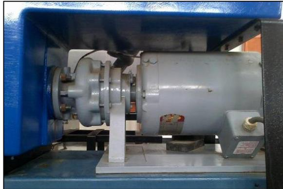
Figura 2. 3– Electrobomba: Bomba centrífuga con motor DC
