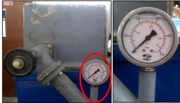
Figura 2. 11–Manómetro de Bourdon en la tubería de ingreso
