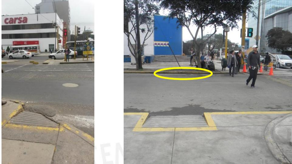
**Figuras 38 y 39:** Rampa mal diseñada y rampa inexistente al frente
