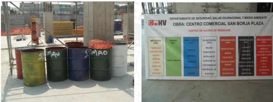
Figuras 3.16 y 3.17: Izquierda - Cilindros metálicos en la obra. Derecha - Cuadro informativo de la distribución de cilindros metálicos por colores. Fuente propia
