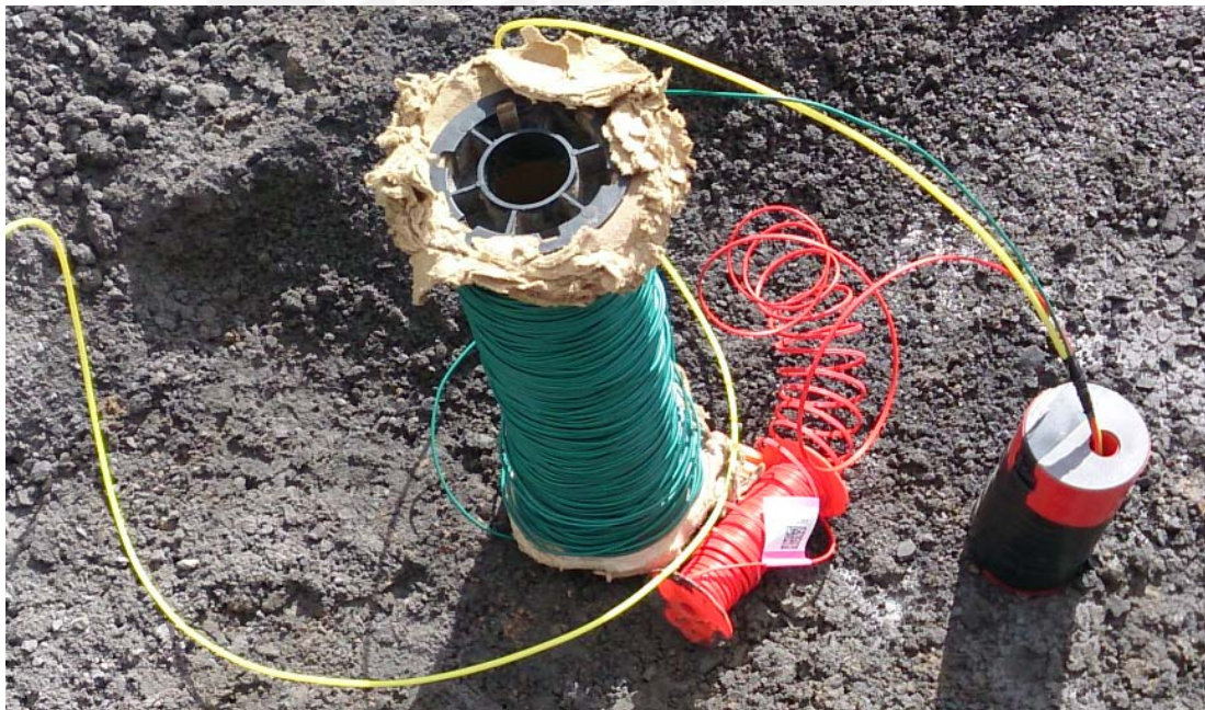
Figura 4-2. Instalación de cable resistivo (verde) junto al booster y tubo de choque
