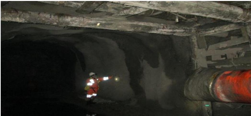
Figura n°46: Sostenimiento con Shotcrete reforzado en terrenos donde antes era sostenido con cuadros de madera
