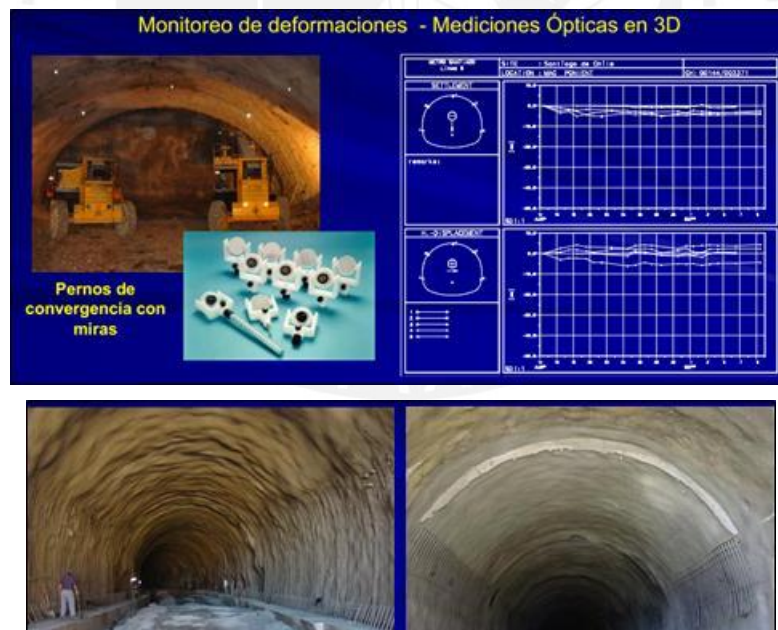
Figura n° 28: Monitoreo de deformaciones
