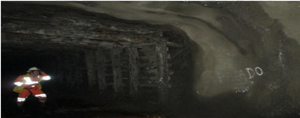
Figura n°46: Sostenimiento con Shotcrete reforzado en terrenos donde antes era sostenido con cuadros de madera
