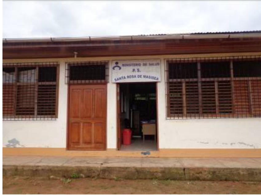
Foto N°7: Puesto de Salud Santa Rosa de Masisea
