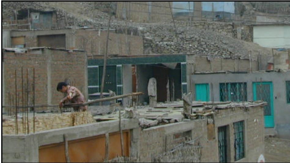
Fig. 2.6 Colocación de la cobertura provisional sobre la vivienda.
