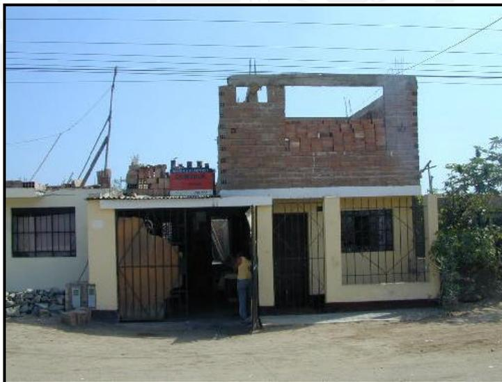
Fig. 2.11 Vivienda con muros para un futuro segundo piso.
