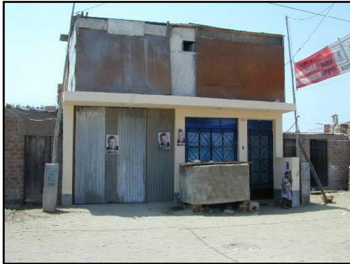
Fig. 2.10 Vivienda con tarrajeo de muros y construcciones provisionales en el segundo piso.
