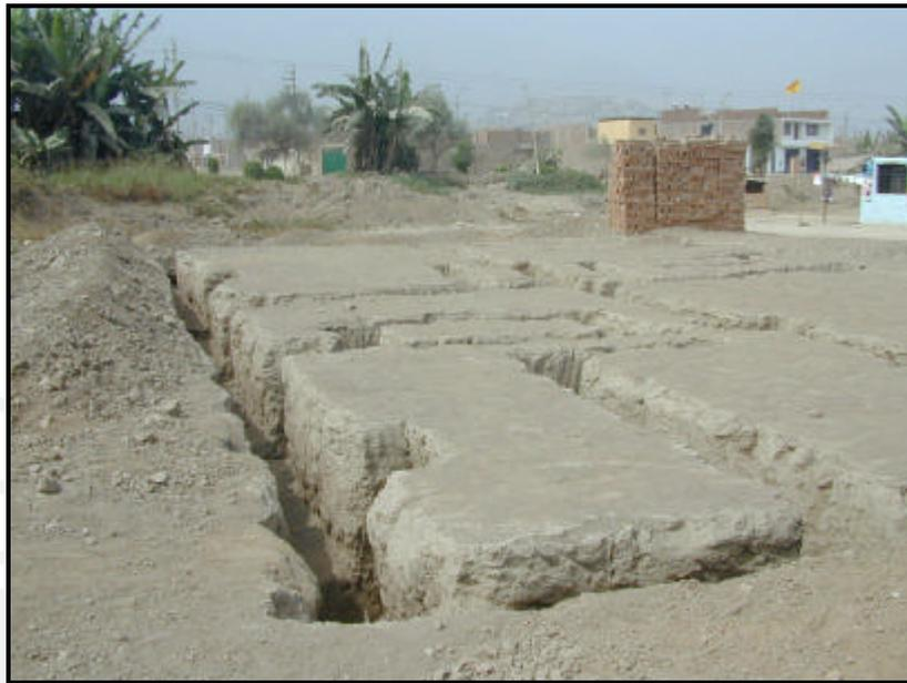
Fig. 2.4 Zanjas para la cimentación.
