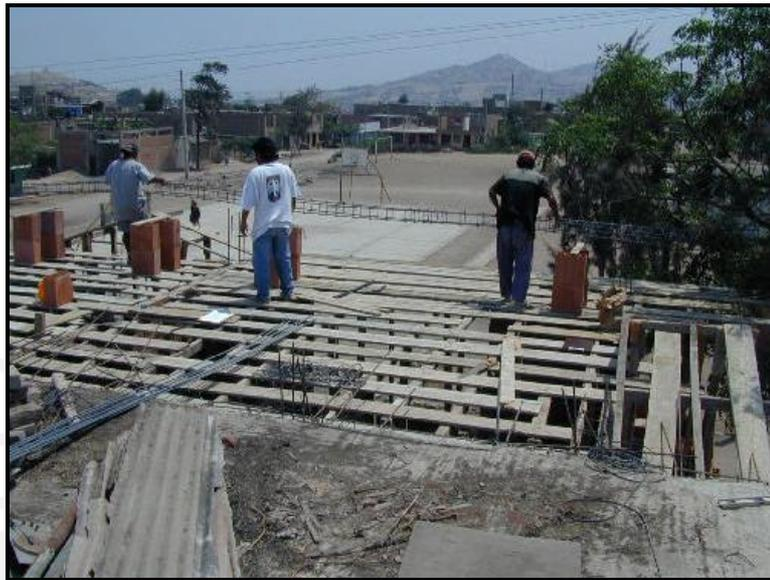
Fig. 2.8 Armado del encofrado para el techado.
