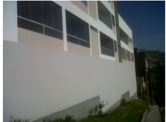
Vista del Pasaje Las Bellotas, desde el lado opuesto de la imagen izquierda. Se observa el frontis del edificio colindante al terreno.
