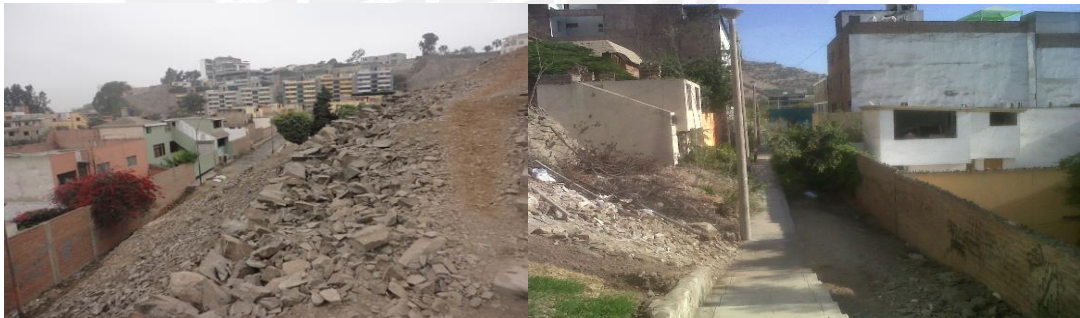
Imagen 31 – Vistas del Pasaje Las Bellotas, denota la necesidad de intervención urbana, la misma que se ejecutará junto con el proyecto y se gestionará con el Municipio para la gestión de recursos y mantenimiento.
