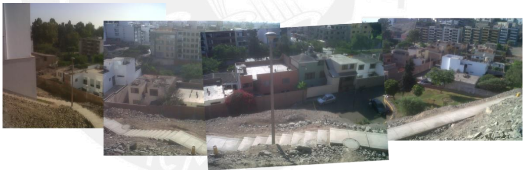
Imagen 25 – Vista desde el terreno, nótense los techos inmediatos
