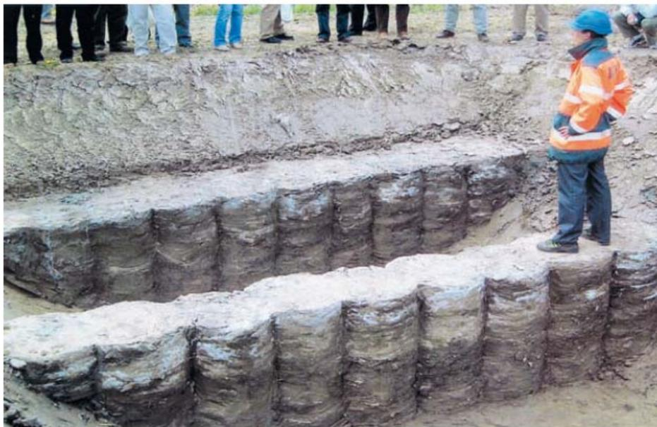
**Figura 4** Distribución de columnas de cal-cemento en fila o panel (Vukotic G. 2006)
