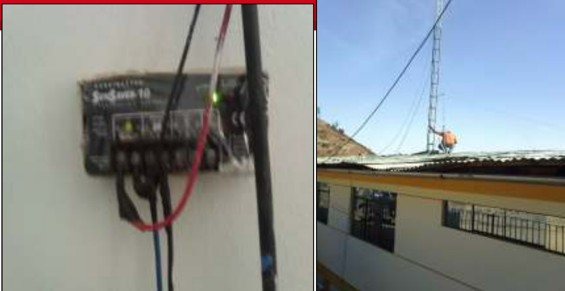
Figura 4.19 Verificando equipos de comunicación
