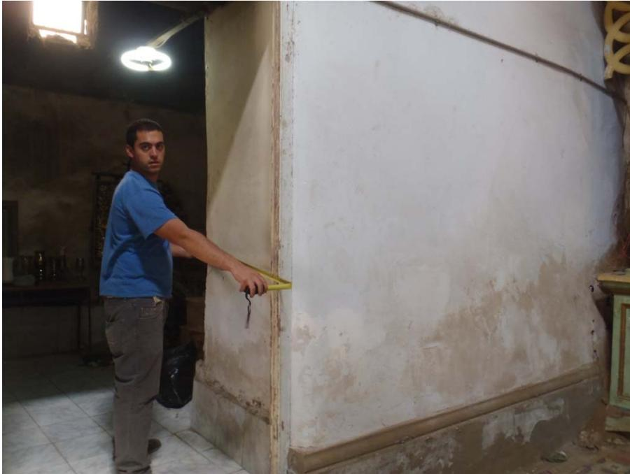
**Ilustración 24 Midiendo Muro interior de vivienda 60cm**
