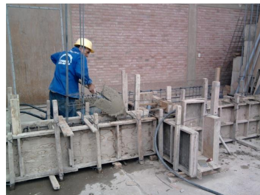
Fig. 4.5.- Colocación Acero de Columnas y Vaciado en Viga de Cimentación
