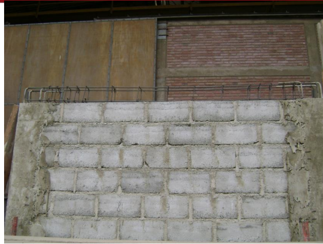
Fig. 4.16.- Muro con Columnas Fraguadas y Desencofradas
