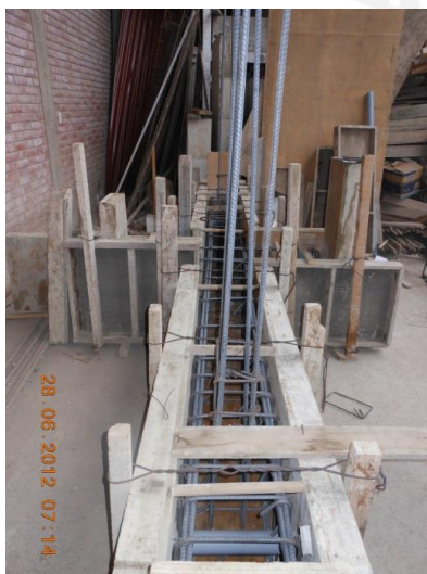
Fig. 4.5.- Colocación Acero de Columnas y Vaciado en Viga de Cimentación
