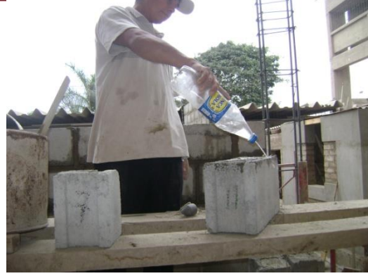
Fig. 4.8.- Relleno y humedecimiento de bloques de albañilería
