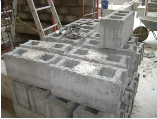
Fig. 4.8.- Relleno y humedecimiento de bloques de albañilería
