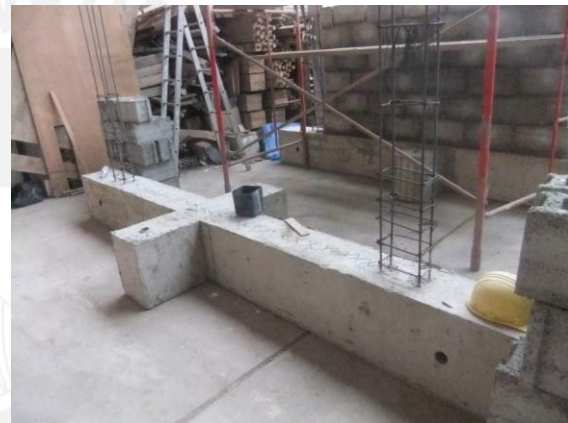
Fig. 4.7.- Control de Probetas y Viga de Cimentación Desencofrada
