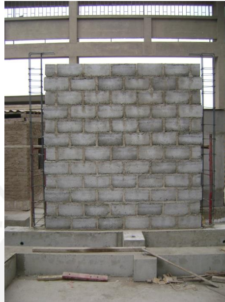
Fig. 4.17.- Conexión Columna con Viga Solera
