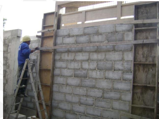
Fig. 4.14.- Encofrado de Columnas
