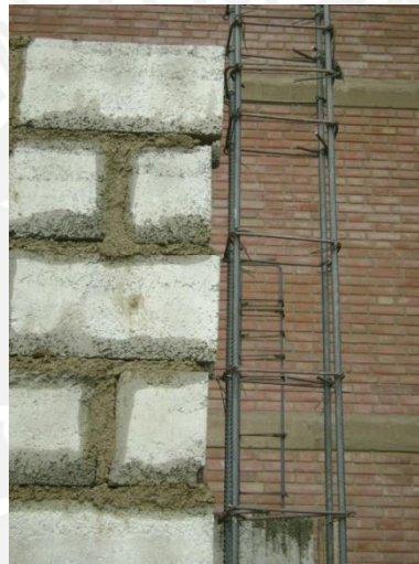
Fig. 4.11.- Muestra de Dentado del Muro
