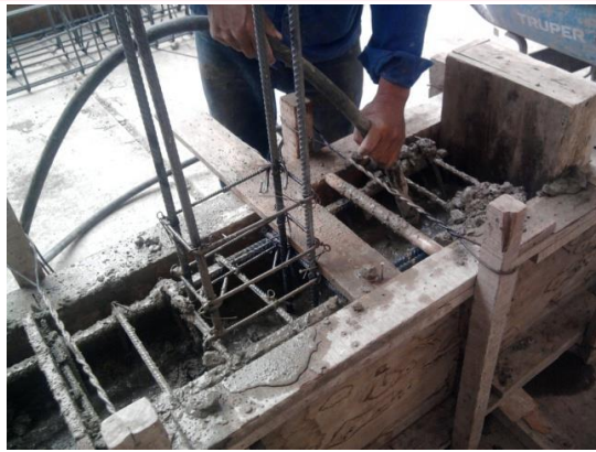
Fig. 4.6.- Vibrado y Alisado de Concreto Fresco
