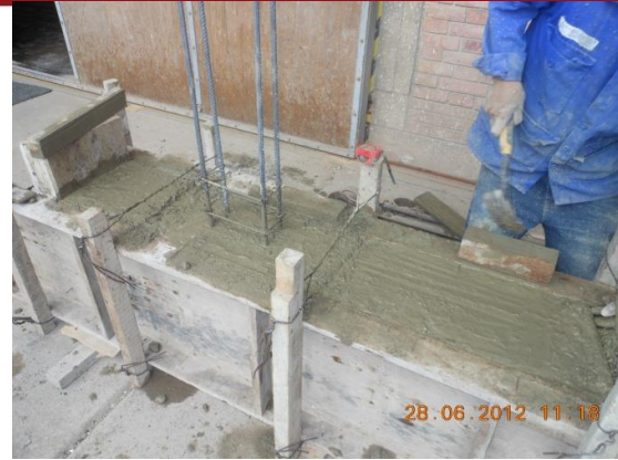
Fig. 4.6.- Vibrado y Alisado de Concreto Fresco
