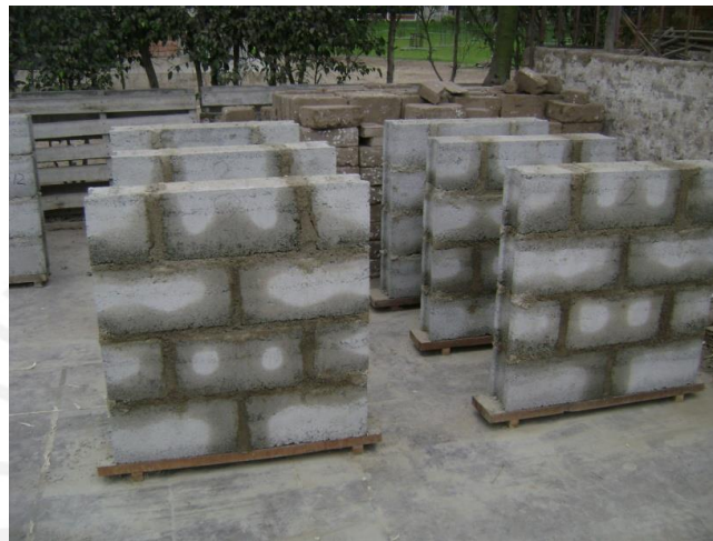
Fig. 3.9.- Colocación de bloques y Muretes curados
