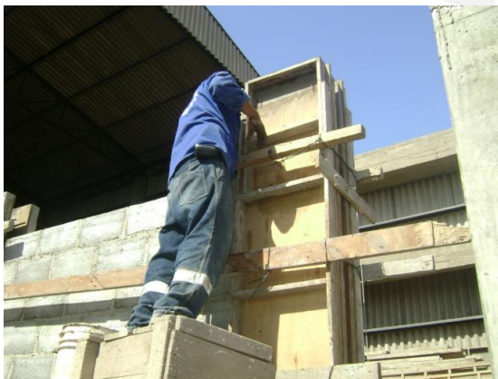
Fig. 4.15.- Ajuste del Encofrado y Vaciado de Concreto
