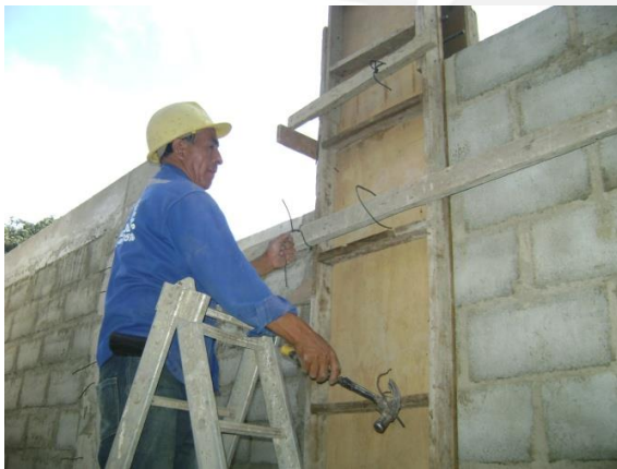
Fig. 4.14.- Encofrado de Columnas
