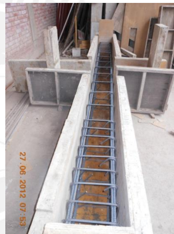
Fig. 4.4.- Habilitación y encofrado de Viga de Cimentación
