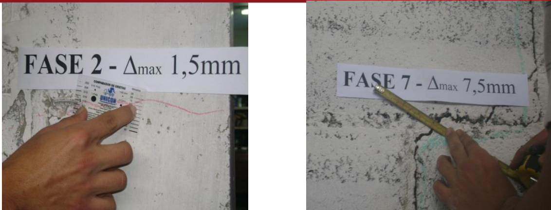
Fig. 6.8b.- Medición de Fisuras en la Fase 2 y 7 del Ensayo
