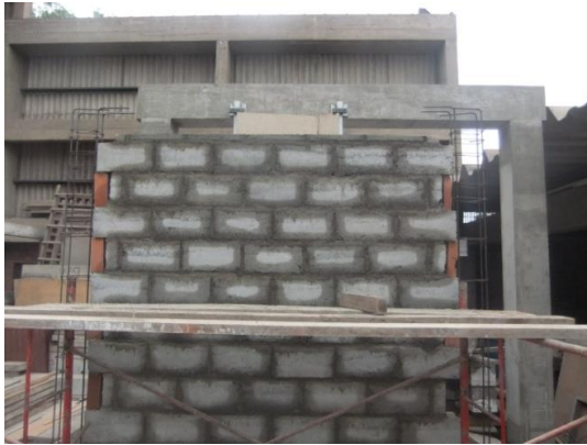
Fig. 4.13.- Limpieza y humedecimiento de bordes verticales
