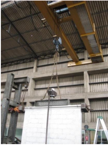
Fig. 6.3.- Izaje y Traslado de Muros
