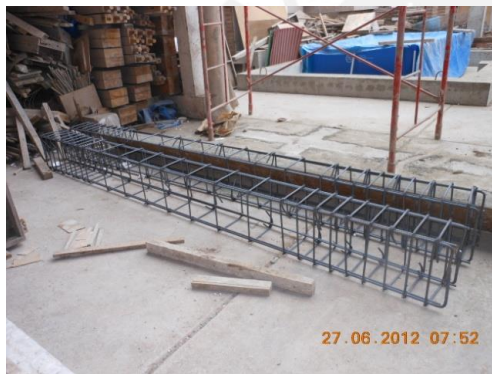
Fig. 4.4.- Habilitación y encofrado de Viga de Cimentación
