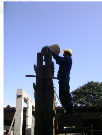
Fig. 4.15.- Ajuste del Encofrado y Vaciado de Concreto
