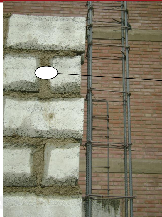
Fig. 4.12.- Junta de 2 cm de espesor
