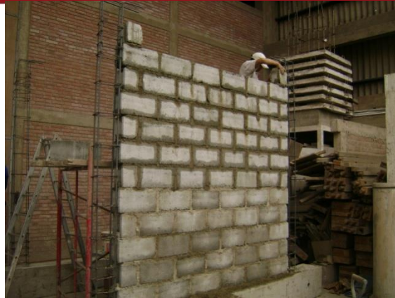
Fig. 4.10.- Culminación de Asentado de Unidades de Albañilería
