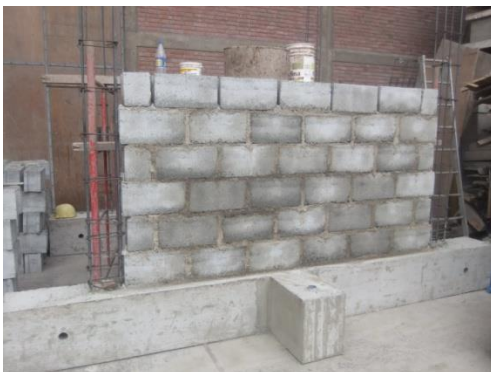
Fig. 4.9.- Jornadas de avance de asentado de bloques
