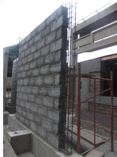
Fig. 4.9.- Jornadas de avance de asentado de bloques
