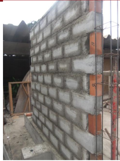
Fig. 4.13.- Limpieza y humedecimiento de bordes verticales
