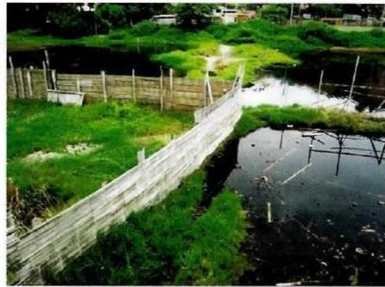
**Foto N°6.** En el lado izquierdo de la foto se muestra un terreno cercado, ganado al humedal al arrojar desmonte. Igualmente al lado derecho se observan un cerco de palos, en una zona con agua, en la que se pretende hacer lo mismo cuando descienda el nivel de agua.
