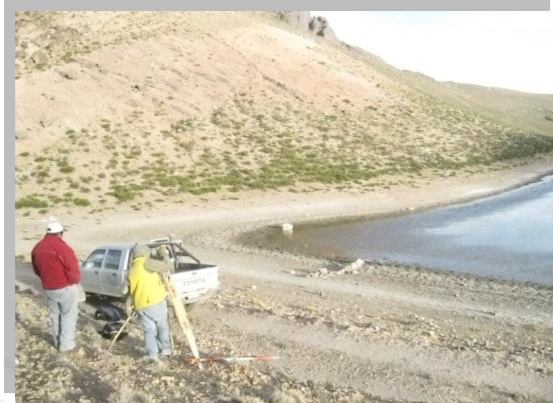
Vista que muestra trabajos de medición topográfica, para la construcción de la micropresa, en la zona de Ichuña provincia General Sánchez Cerro - Moquegua.
