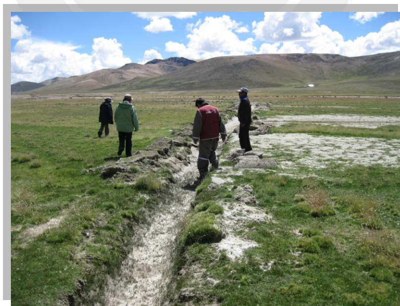
Vista que muestra encausamiento de aguas, fruto de micropresas en la zona Carumas provincia de Mariscal Nieto - Moquegua,
