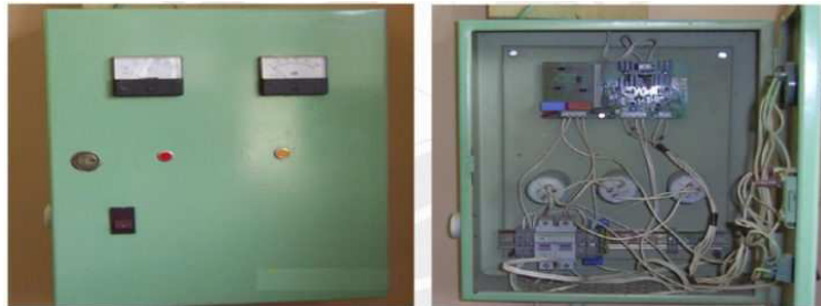
Figura 3.23. Controlador de generación de inducción [Ref. 25].
