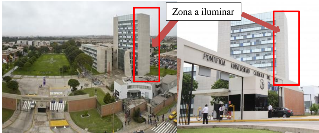
Figura 3.4 Edificio C del complejo Mc Gregor visto desde fuera de la universidad
