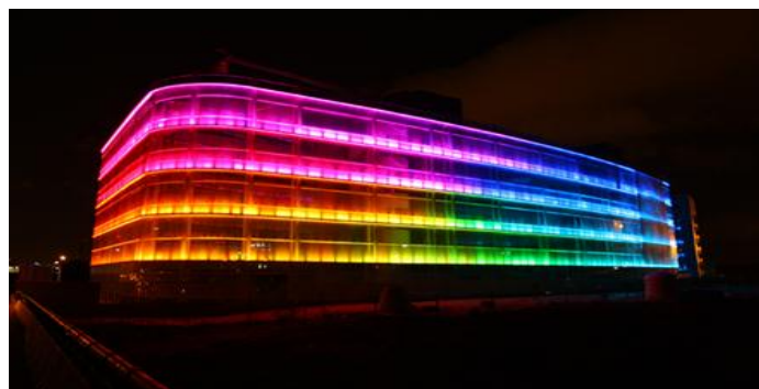
Figura 1.8 Edificio Ebro, en Madrid España
