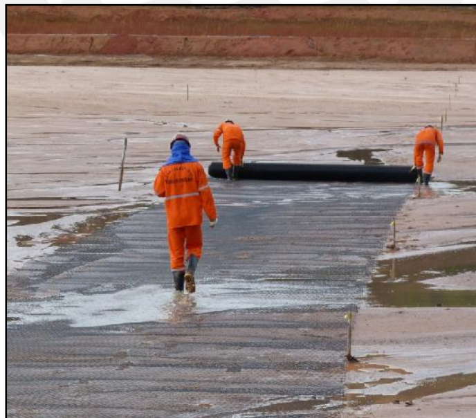
Figura 11. Colocación de geomallas para construcción de diques sobre bofedales
