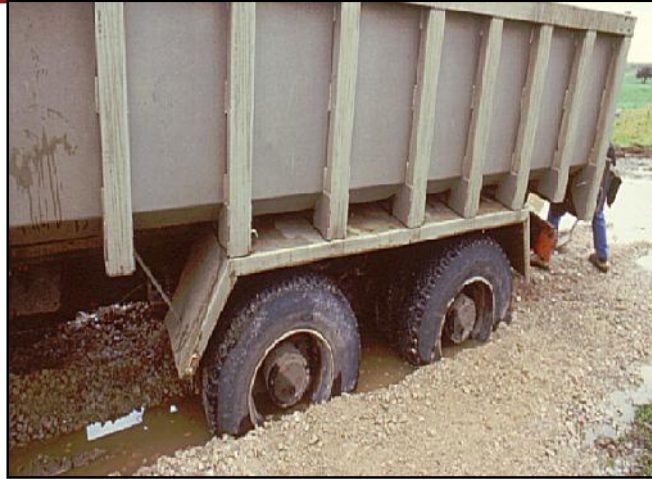
Figura 09. Problemas presentados en la superficie debido a la presencia de subrasantes blandas
