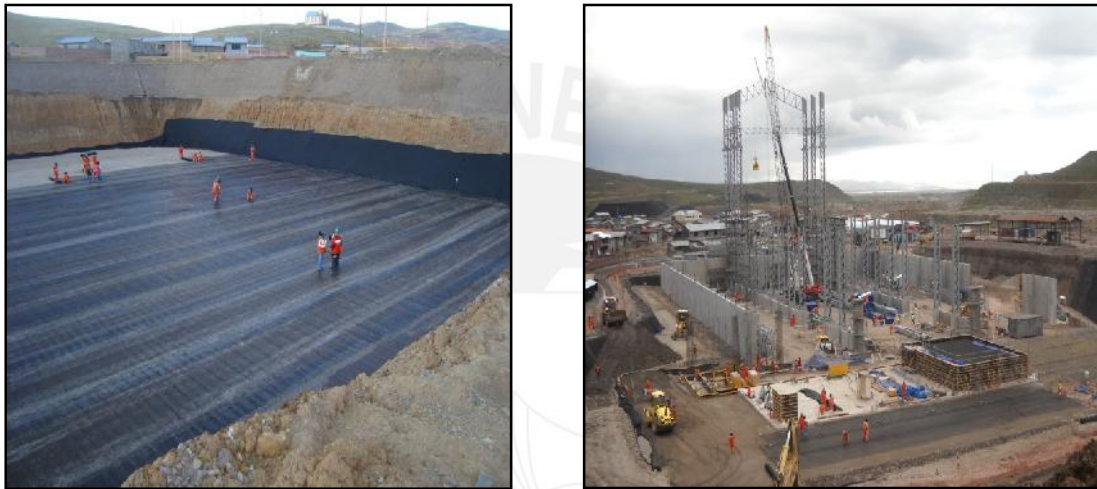
Figura 12. Mejoramiento de fundación en una planta de molienda y flotación
