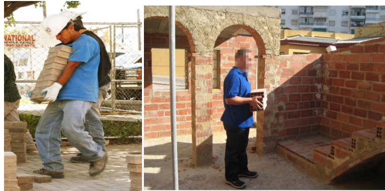
Figura 3.21: Las cargas deben permanecer pegadas al cuerpo no deben ser excesivas. Fuente: http://www.lineaprevencion.com
