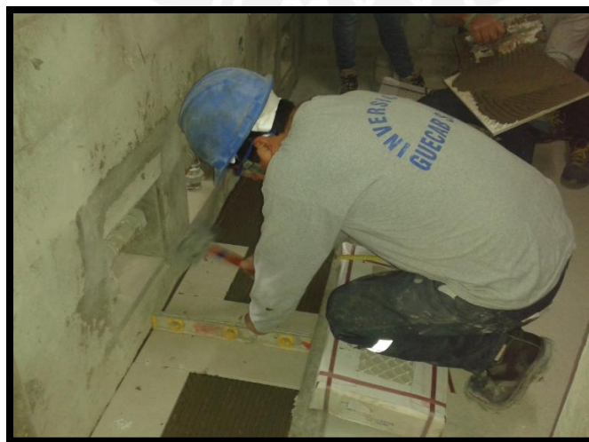
Imagen 32. Personal enchapando porcelanato en baños (Propia)
