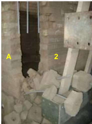
Fig.8.8. Fase 2. Desacople de los tubos en la esquina 2-A.
