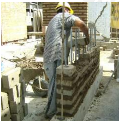
Fig.6.7. Asentado del bloque con su cara superior
