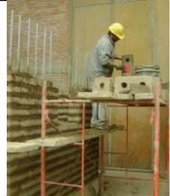
Fig.6.6.Humedecimiento de la base del bloque.
