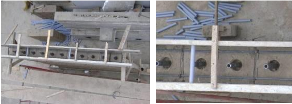
Fig.6.27. Encofrado de la solera del muro M2.
