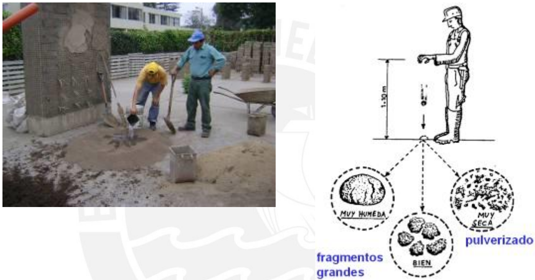
Fig.2.5. Preparación de la mezcla y prueba de campo para medir el contenido de humedad.
