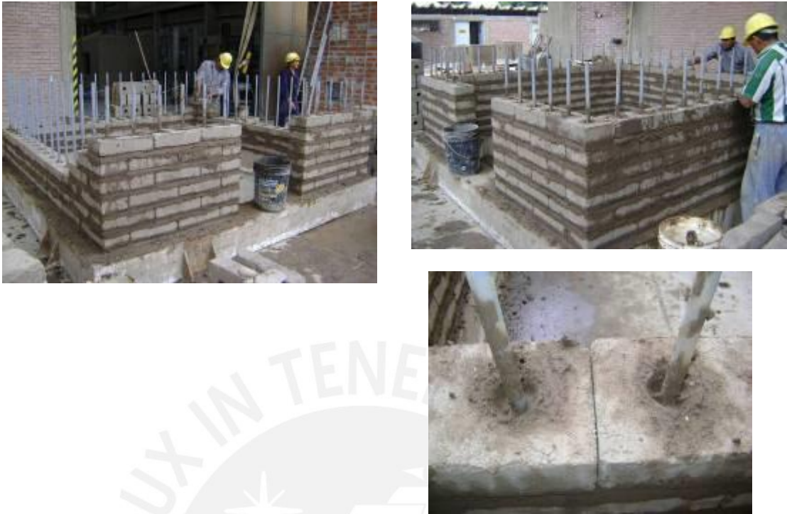
Fig.6.17. Construcción de la mitad inferior del módulo, llenando con mortero a media altura los alvéolos, para después humedecer la cara superior y asentar el bloque de la siguiente hilada con su base humedecida.
