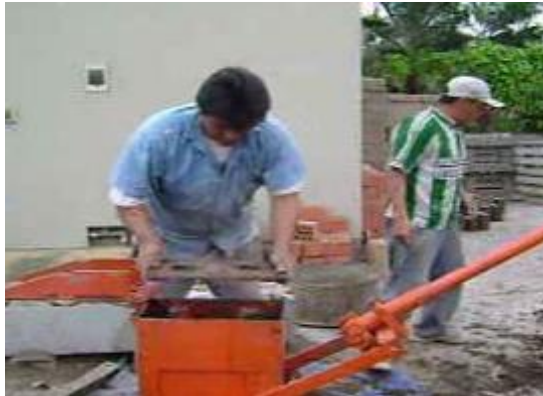
Fig.3.2 Instalación de base.
