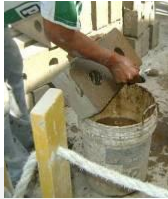
Fig.6.6.Humedecimiento de la base del bloque.
