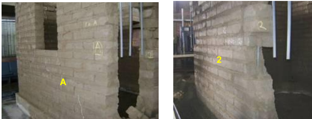
Fig.8.12. Fase 2. Zona central del muro de corte "A" y del muro de flexión "2", sin problemas en los empalmes de los tubos.
