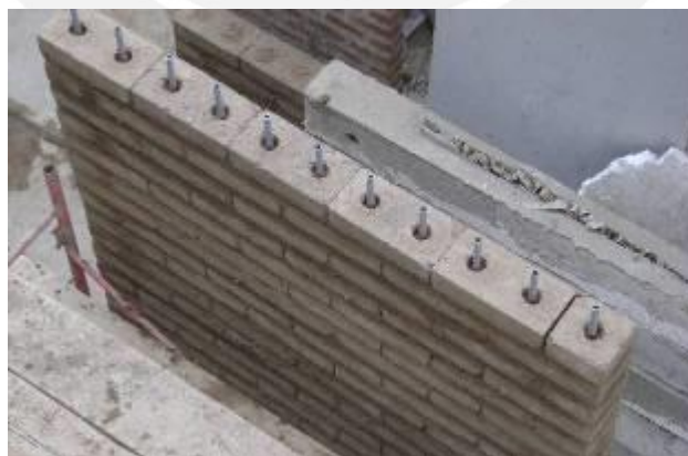
Fig.6.13 Última hilada de M2. Relleno con barro a media altura de los alvéolos, dejando vacía la mitad superior.
