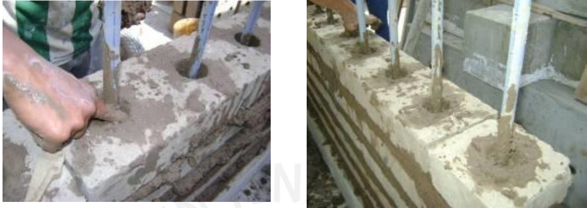
Fig.6.9. Compactación del mortero en los alvéolos del bloque a \frac{1}{2} altura.
