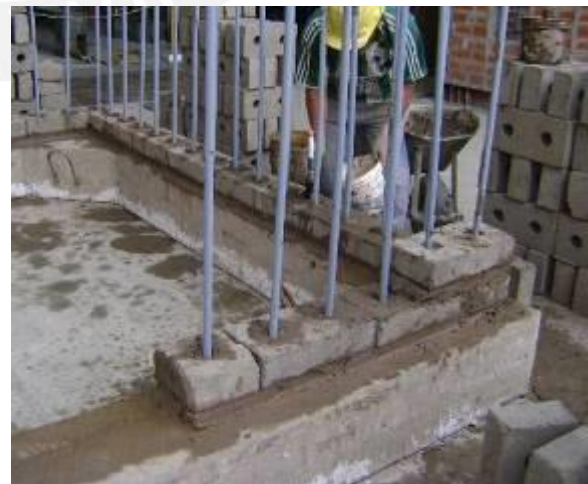
Fig.6.8. Humedecimiento de la cara superior.
