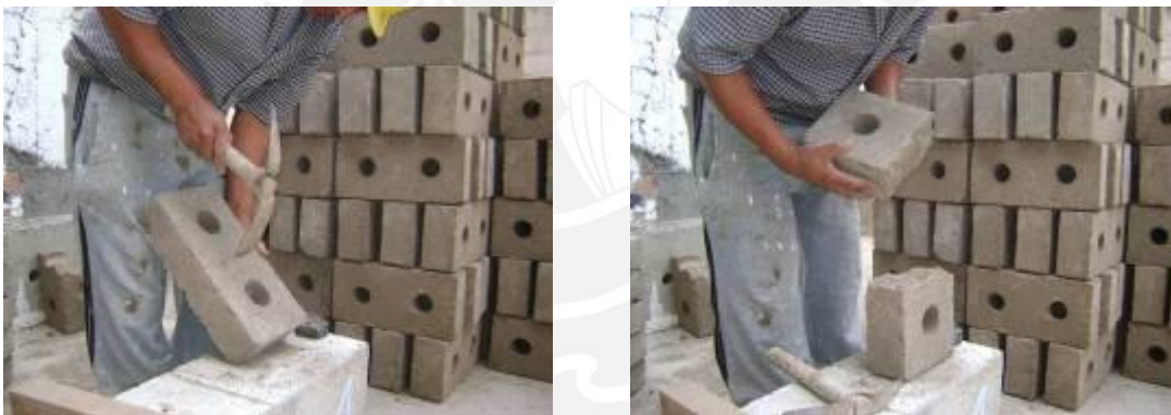
Fig.6.1. Uso de la picota para cortar bloques, el lado recortado se colocó dando hacia una de las caras externas del muro.
