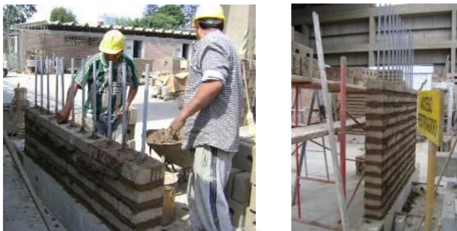
Fig.6.14. Etapas de la construcción de M2. Nótese la altura de los tubos y su verticalidad. A la derecha los tubos ya están acoplados.
