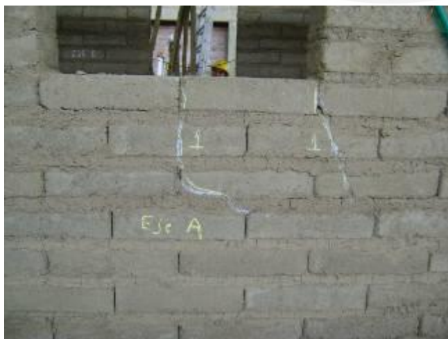
Fig.8.4. Fase 1. Fisuras en el alféizar del eje A. El resto de muros un tuvo fisuras.
