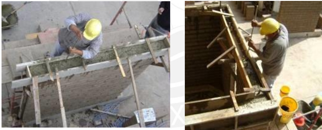
Fig.6.30. Compactación del concreto en el muro y en el módulo.
