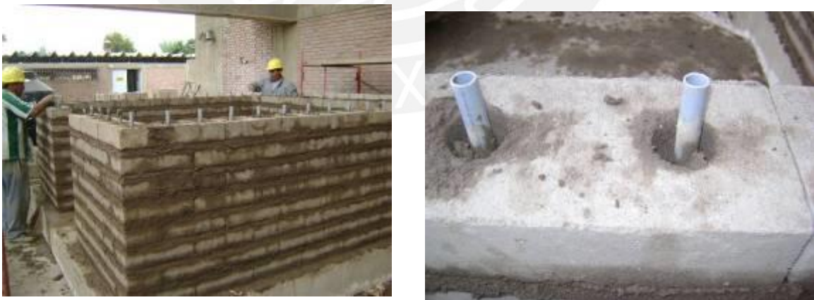
Fig.6.18. Zona de empalme de tubos y alvéolos a medio llenar.
