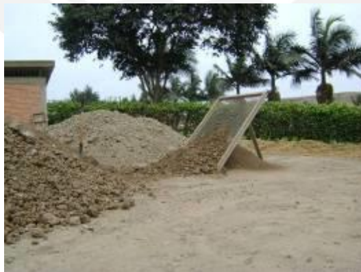
Fig.2.4 Tamizado de suelo
