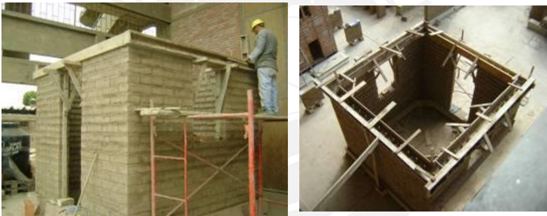
Fig.6.28. Encofrado de la solera del módulo.
