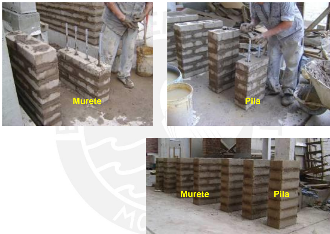
Fig.6.11 Construcción de las pilas y muretes.
