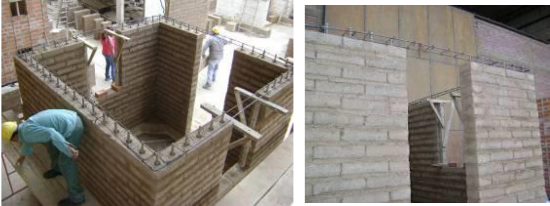
Fig.6.23. Presentación del refuerzo de la solera del módulo.
