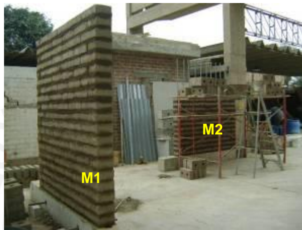
Fig.6.12 Construcción de los muros M1 y M2.
