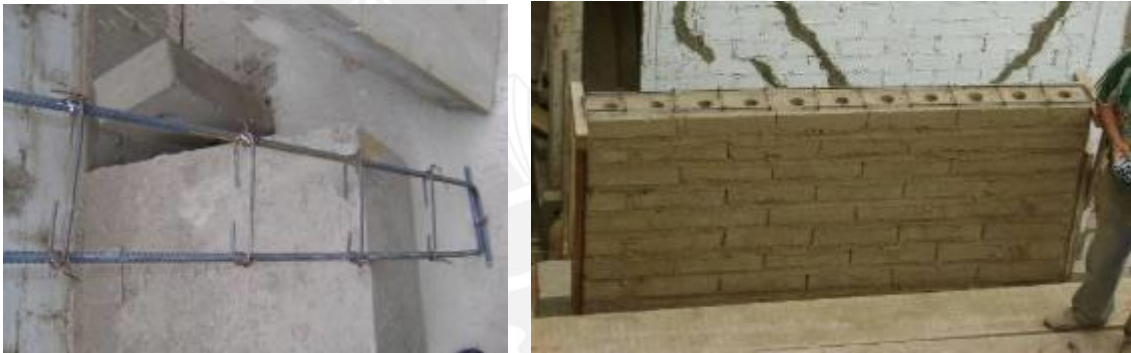
Fig.6.21. Presentación del refuerzo de la solera para los muros M1 y M2.
