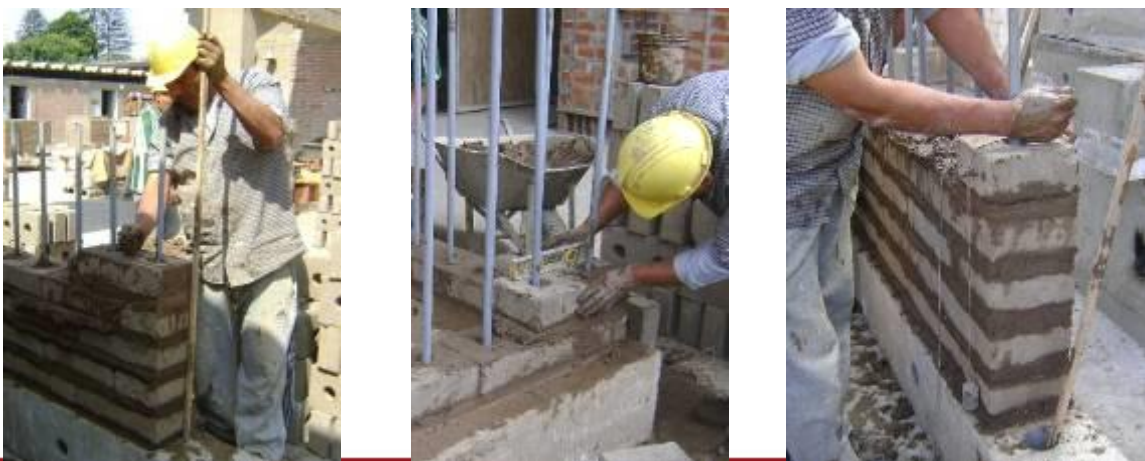
Fig.6.2. Escantillón.
