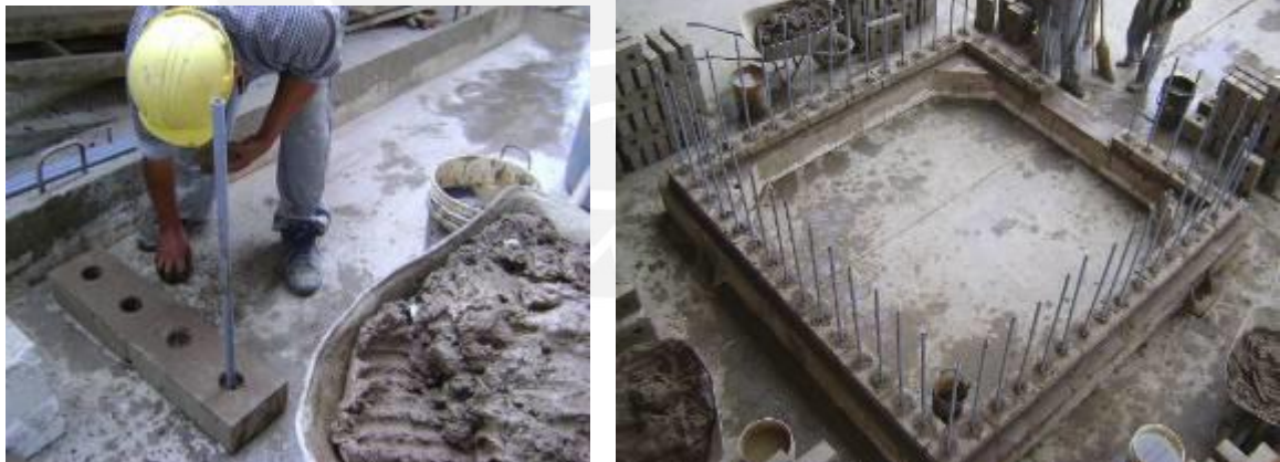
Fig.6.10. Instalación de los tubos en la primera hilada, nótese su verticalidad.
