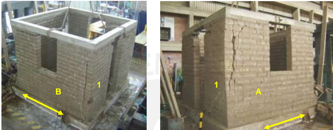
Fig.8.6. Fase 2. Grietas verticales en los extremos del eje 1. Nótese que no atraviesan la solera y se estancan en la tercera hilada.
