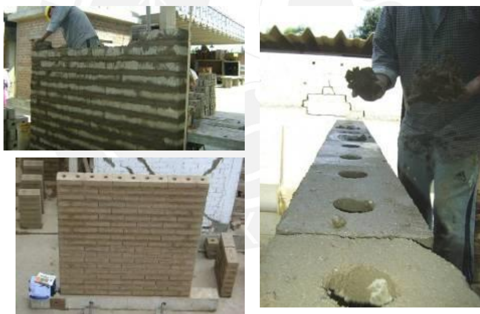
Fig.6.15. Muro M1 (sin tubos) y taponado de los alvéolos a media altura de los bloques de la última hilada.
