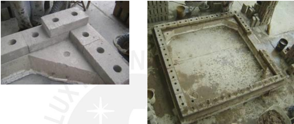
Fig.6.15. Emplantillado de los bloques y construcción de la primera hilada.
