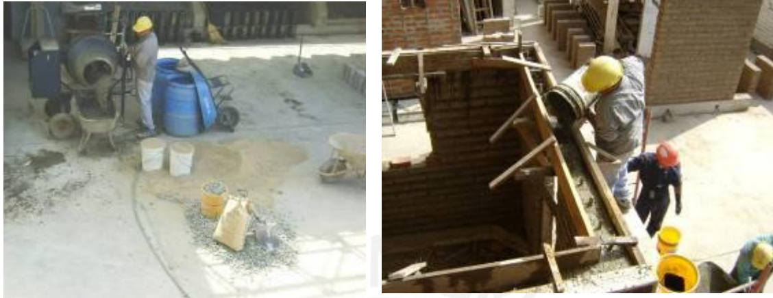
Fig.6.29. Preparación del concreto y vaciado.
