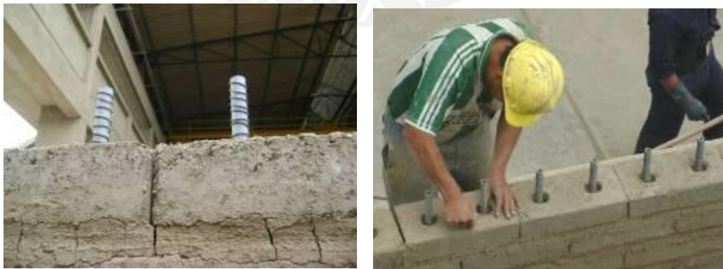
Fig.6.25. Espiralado de la parte superior del tubo con alambre #16.
