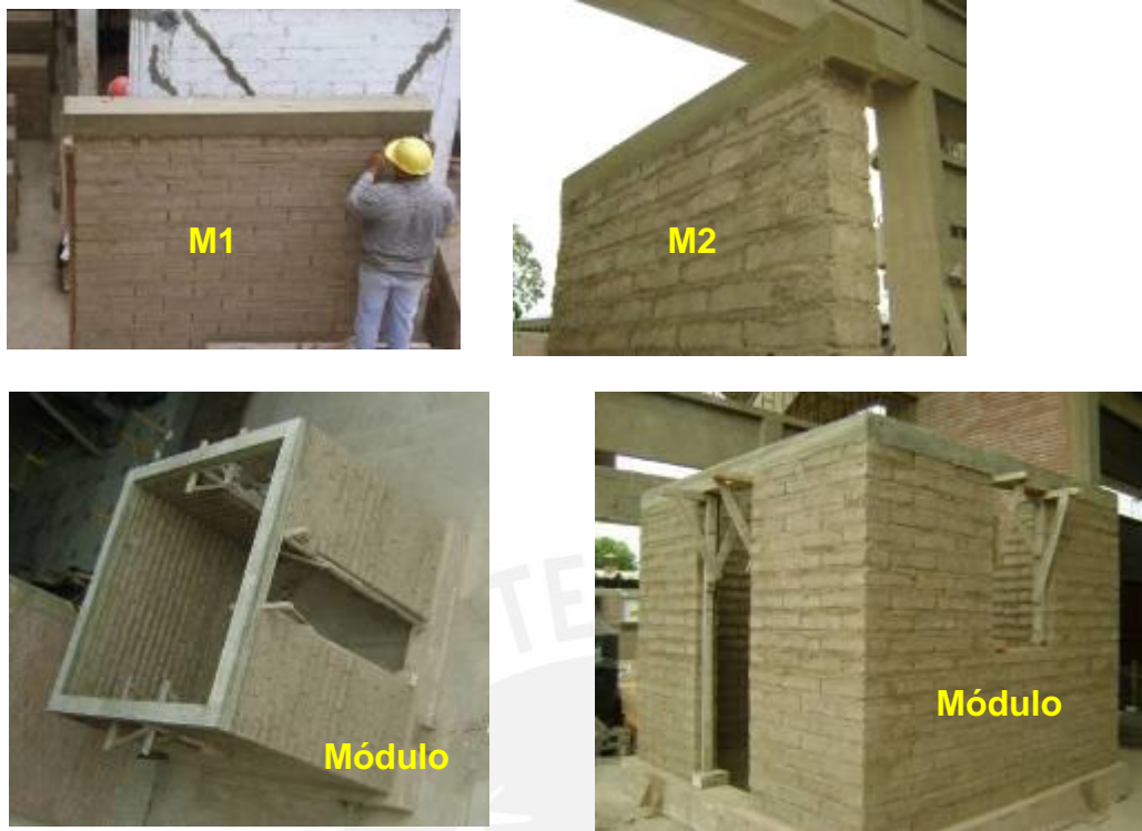
Fig.6.31 Vigas solera desencofradas.
