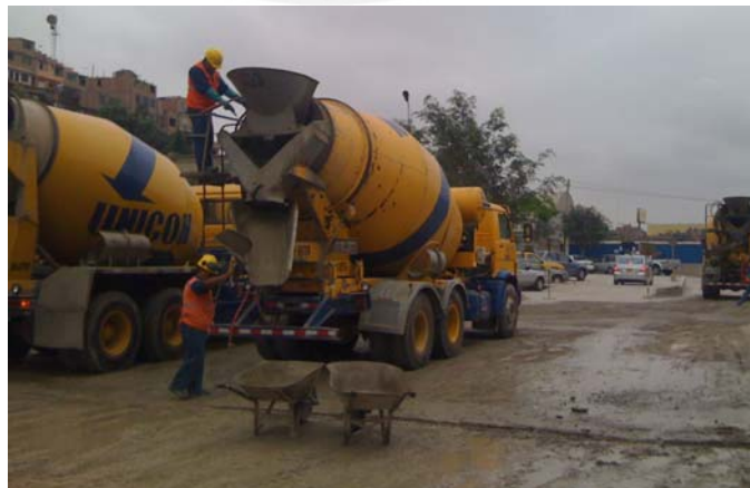
Imagen 5.12: Muestreo de mezcla obtenida de producción a Escala Industrial
