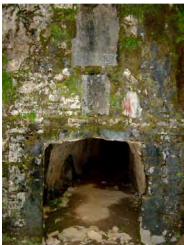
Fig. 18. Entrada al socavón de Nuestra Señora de Belén (Foto L. Vetter).
