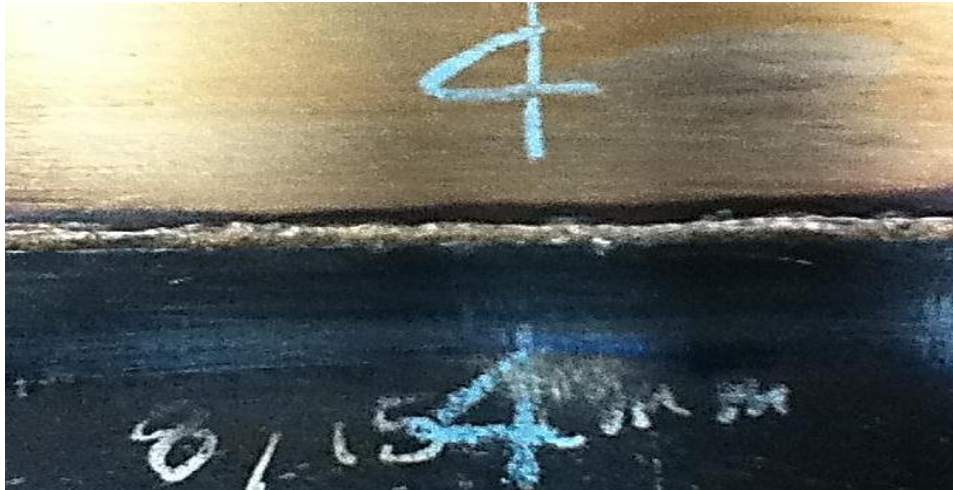
Figura 3.1. Raiz del cordón de soldadura del cupón 2
