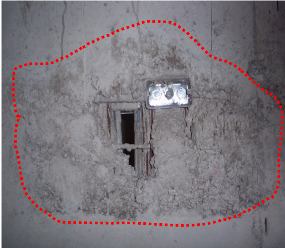
Fig. 4.2. Cangrejeras-Obra: Los Algarrobos.
