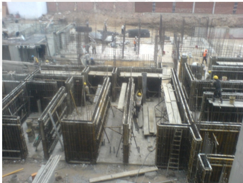
Fig. 5.1. Encofrado de muros listo para el vaciado-Obra Condominio Villa del Sol
