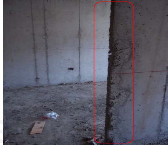
Fig. 4.3. Cangrejeras-Obra: Los Algarrobos.
