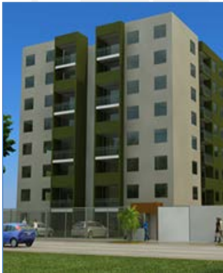
Fig. 5.2. Vista del Edificio concluido
