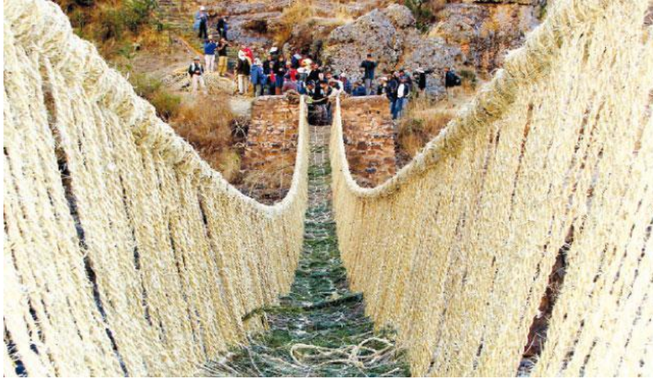
Figura N° 4.2: Vista del puente colgante Q'eswachaka ubicado sobre el río Apurímac en el Cuzco, cada año los pobladores renuevan sus fibras en un acto culto.
