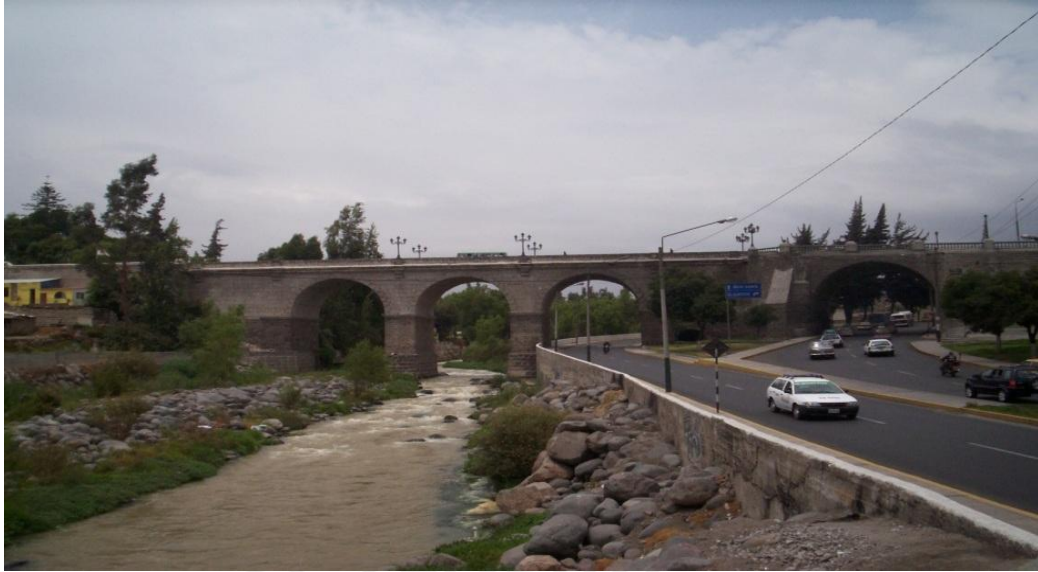
Figura N° 4.10: Puente Grau sobre el río Chili en la ciudad de Arequipa, con sus tres arcos de medio punto, y el cuarto arco construido en los 70's.
