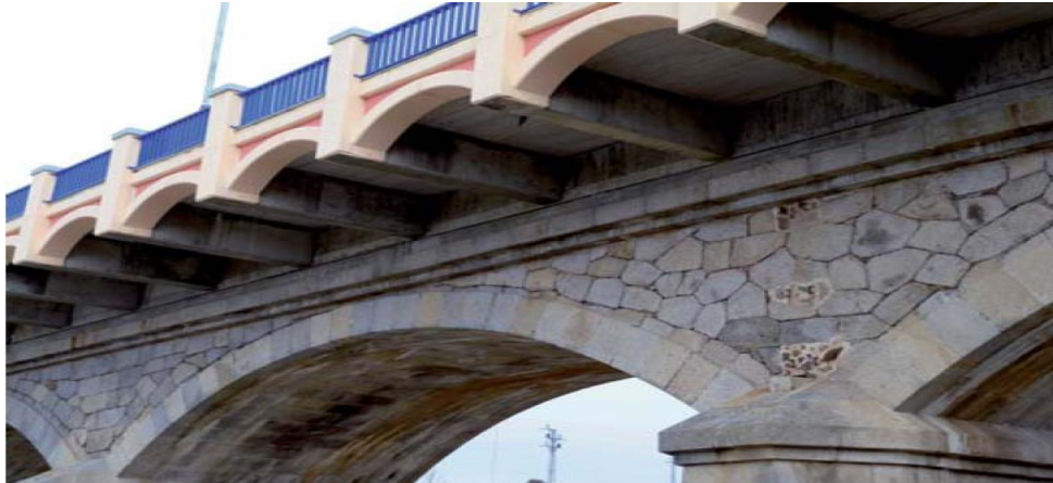
Figura N° 3.38: Ensanche con voladizos laterales.
