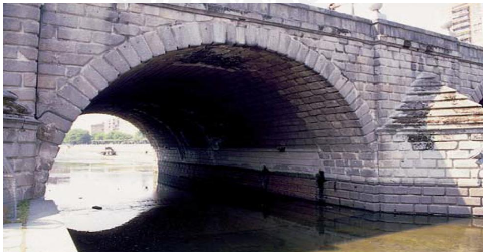
Figura N° 3.38: Ensanche mediante traslación del paramento.
