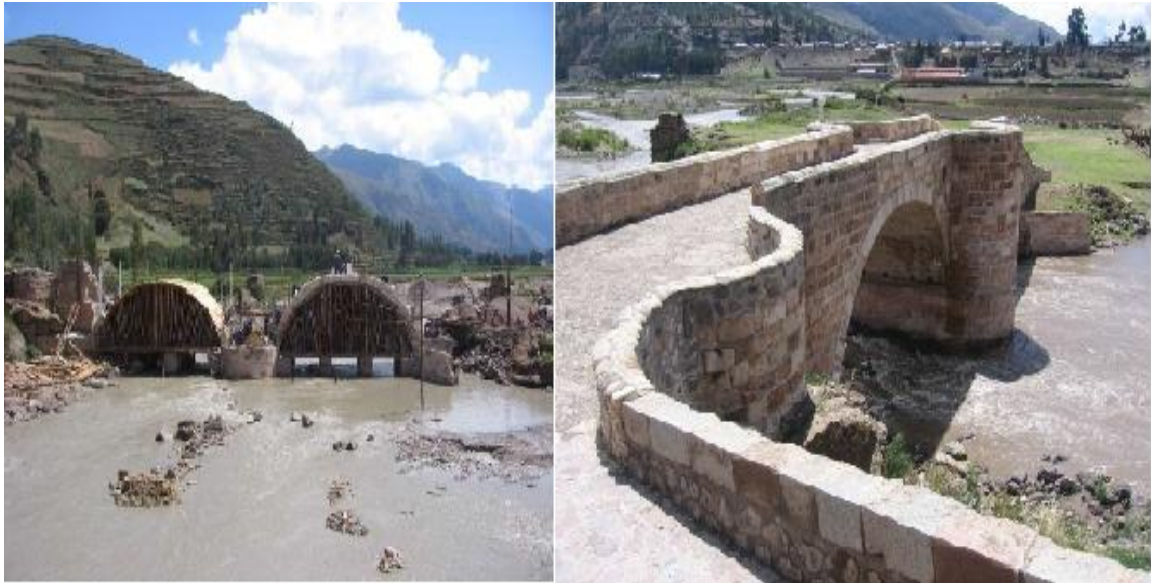
Figura N° 3.38: Reconstrucción de un puente en el Cuzco - Perú.
