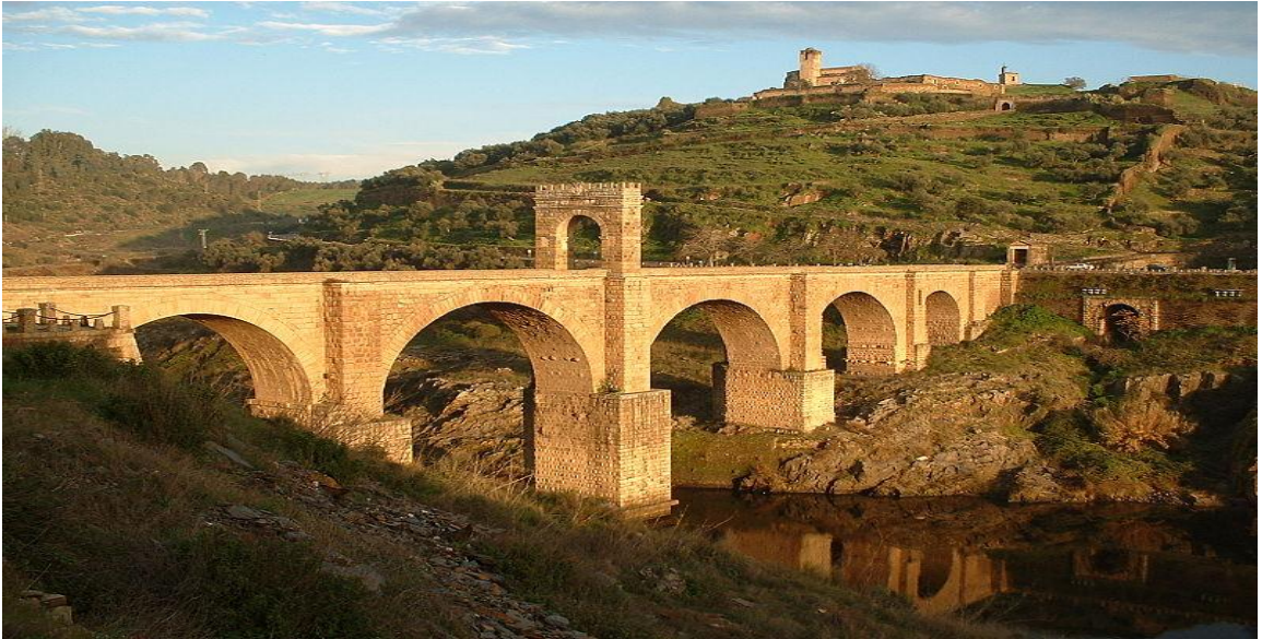
Figura N° 3.3: Puente de Alcántara sobre el rio tajo con 194 m. de luz, hecho a base de sillares de roca granítica, construido entre los años 104 y 106 d.c.
