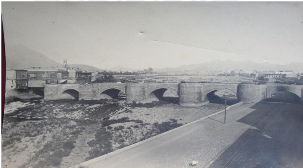
Figura N° 6.3: Vista del puente en 1890, desde donde hoy se conoce la alameda Chabuca Granda, observamos que posee sus seis arcos, y la vía del ferrocarril que va hacia el callao.
