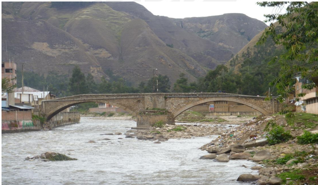
Figura N° 4.17: Vista del puente Cáceres.
