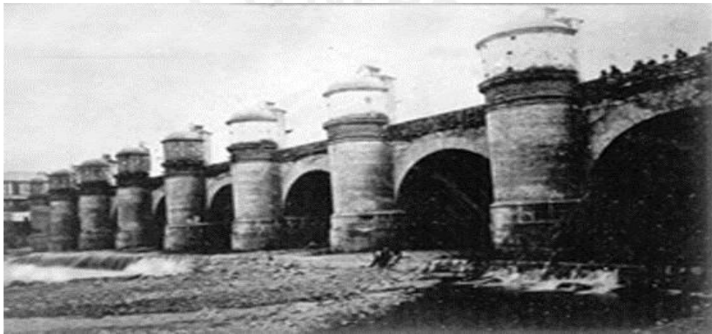
Figura N° 3.38: Antiguo Puente de Calicanto en Santiago de Chile en 1888, posteriormente demolido. Actualmente se encuentra la estación calicanto del metro en dicha ciudad.
