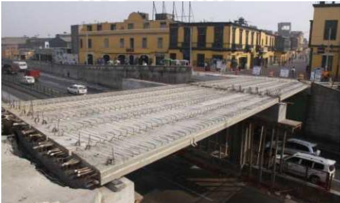
Figura N° 6.8: Trabajos de colocación de losas prefabricadas en el puente Trujillo, realizados en Mayo del 2009 para dar más altura libre en este punto de la vía de evitamiento.
