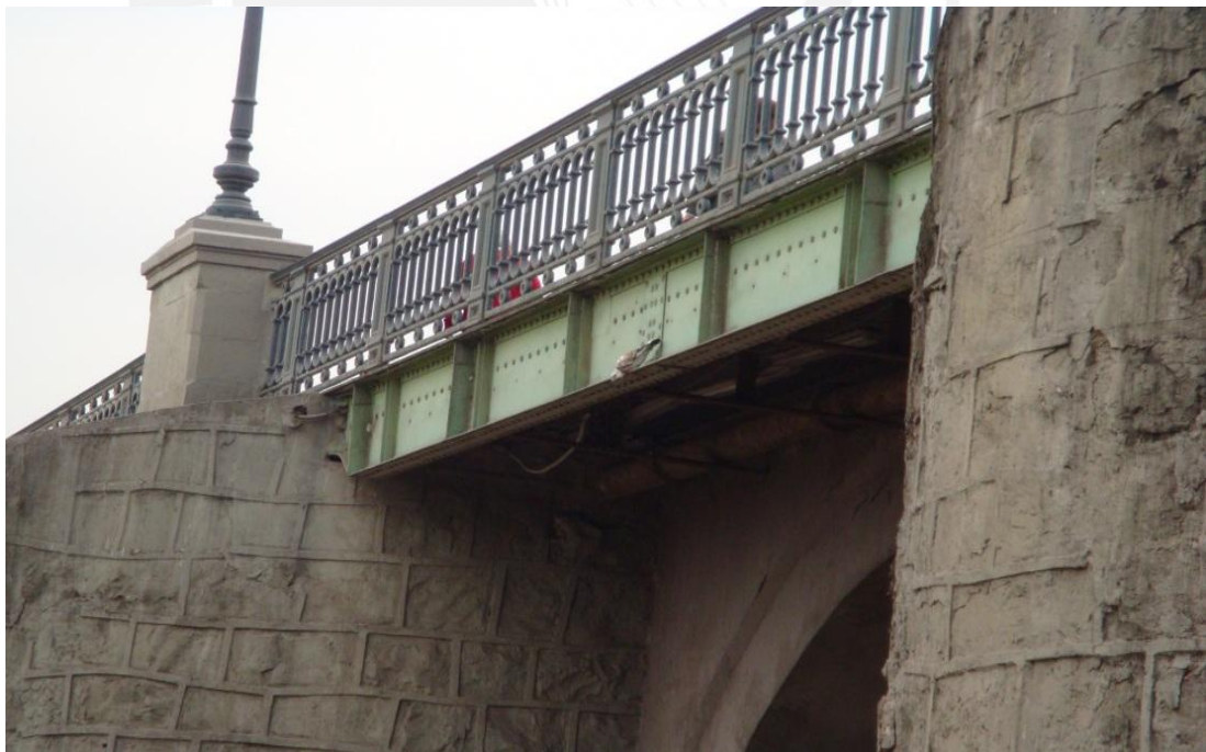
Figura N° 6.10: Se observa el perfil metálico que posee el puente apoyado sobre los pilares. Además se puede ver los barandales de fierro fundido.
