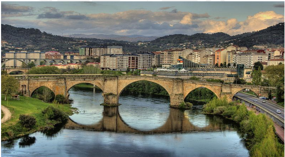
Figura N° 3.5: Puente Vella de Ourense sobre el río Miño, reconstruido en el siglo XIII sobre las bases de un puente romano del siglo I, su arco principal mide 38 m.
