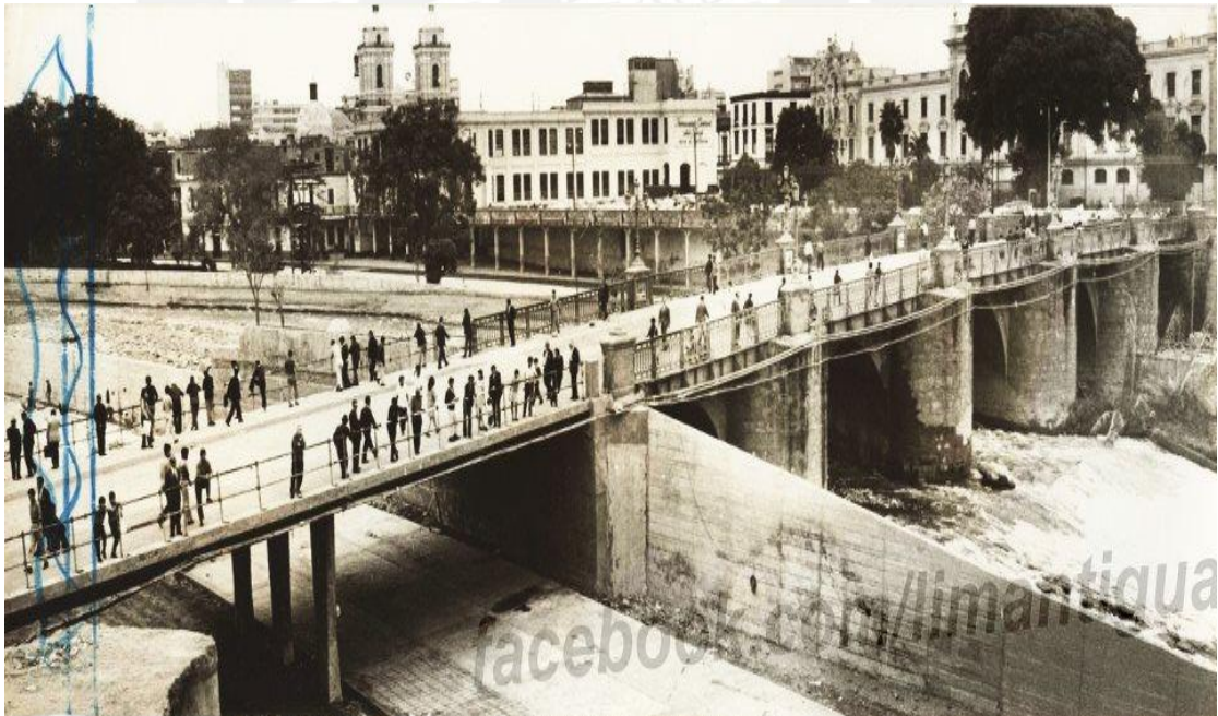
Figura N° 6.7: Se observa el puente postensado colocado conjuntamente al puente Trujillo, imagen difundida también por el diario La Prensa en los años 60.
