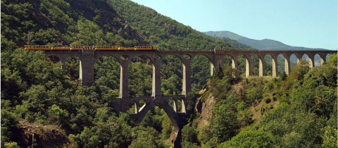
Figura N° 3.10: Viaducto de Fontpedrouse, cruza el río Tet, posee arcos de 17 metros de luz y un arco ojival de 30 m. de luz, terminándose de construir en 1908.
