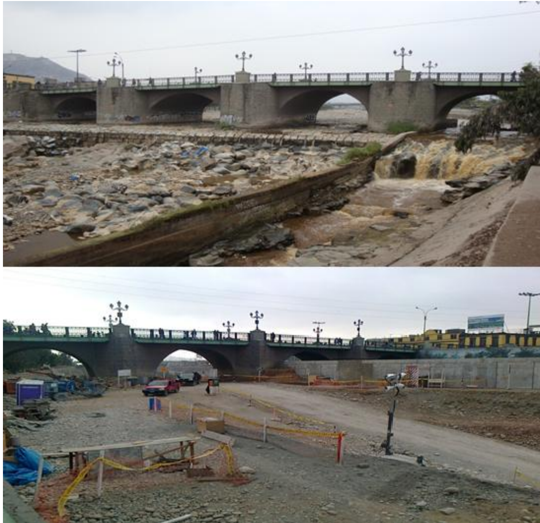
Figura N° 4.5: (Arriba) Vista aguas arriba del río Rímac. (Abajo) Vista aguas abajo del río Rímac, nótese los primeros trabajos de la obra vía parque Rímac.
