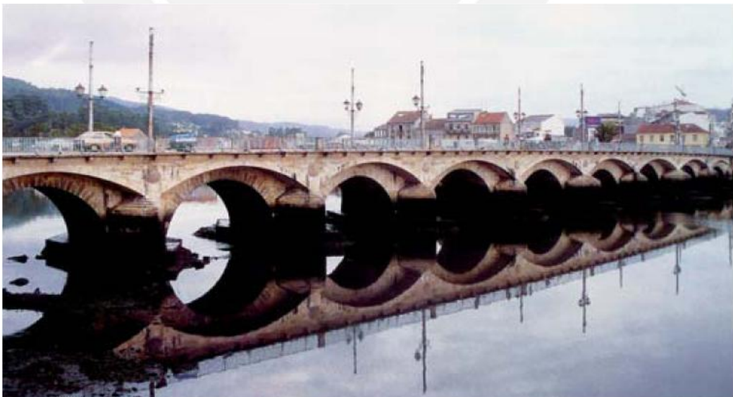
Figura N° 3.38: Ensanche con bóvedas de concreto adosadas.
