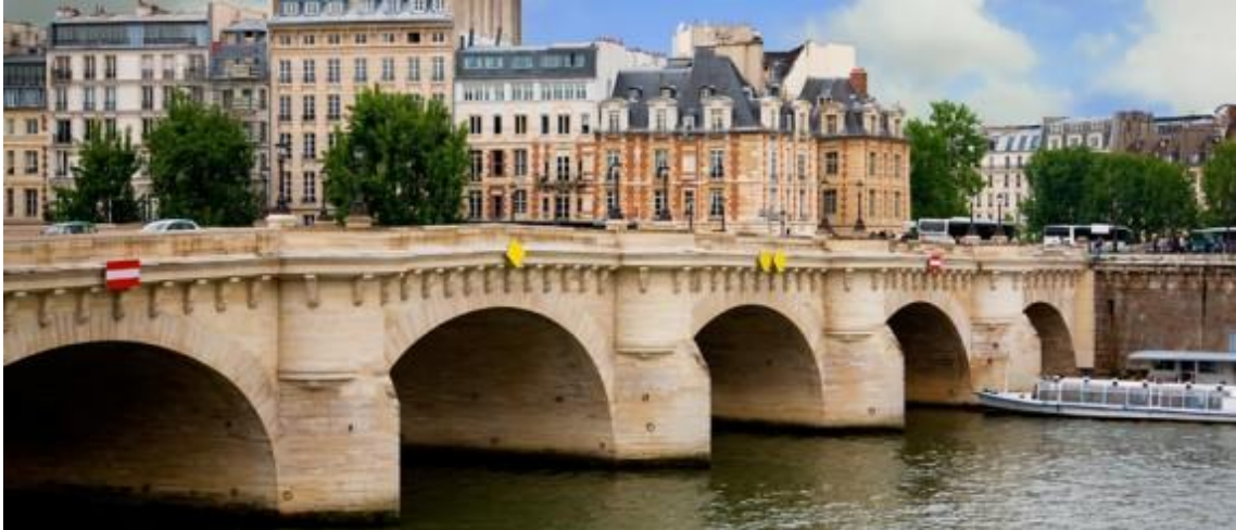
Figura N° 3.8: Puente Nuevo (Puente Neuf) del siglo XVI sobre el río Sena, con una longitud de 232 m. repartido en dos tramos por una isla que cruza., fue el primer puente de piedra construido en París.
