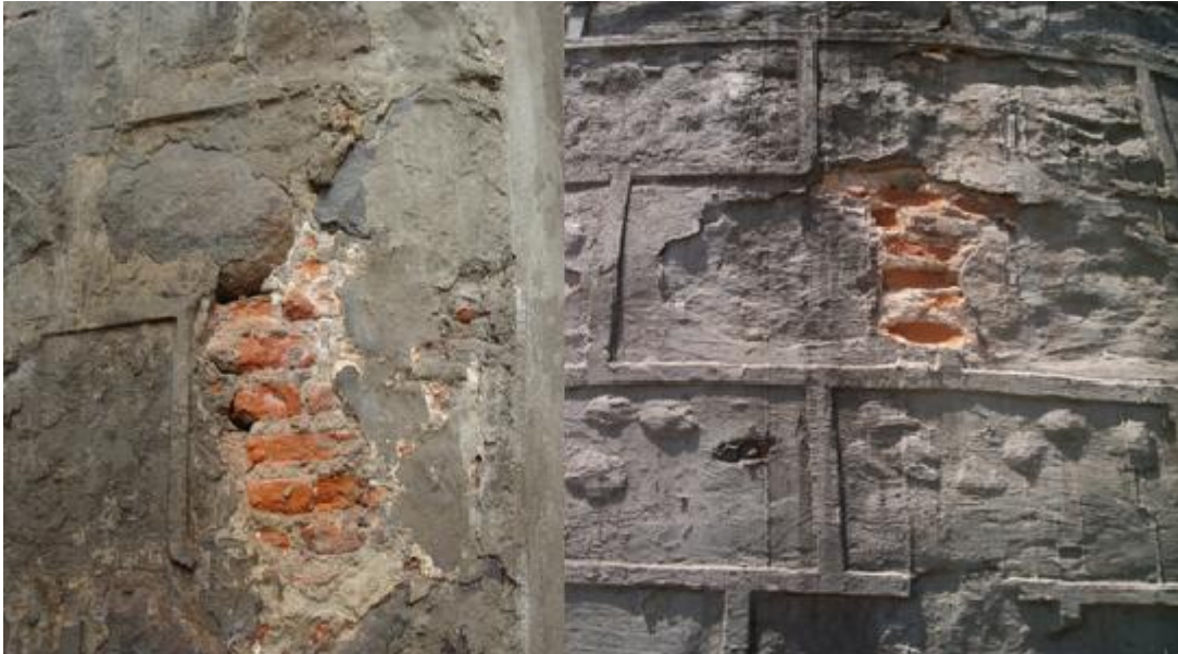
Figura N° 6.14: Piedras y ladrillos usados en la mampostería del pilar, además podemos notar un tarrajeo de concreto que simula a una mampostería de sillería regular.
