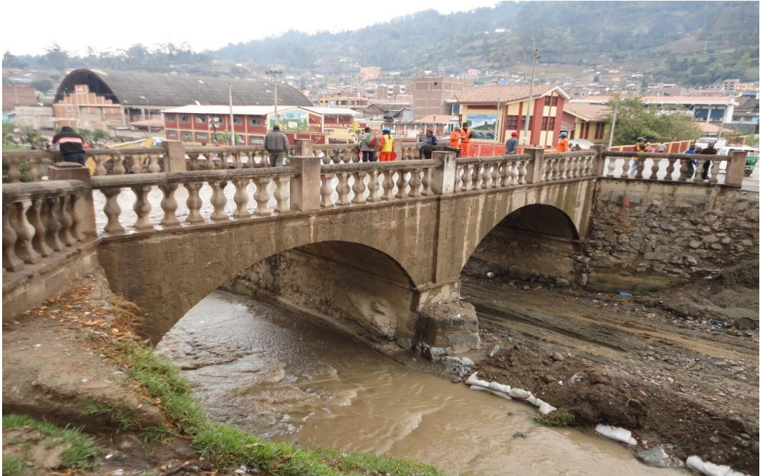
Figura N° 4.14: Vista del puente de Chincha.
