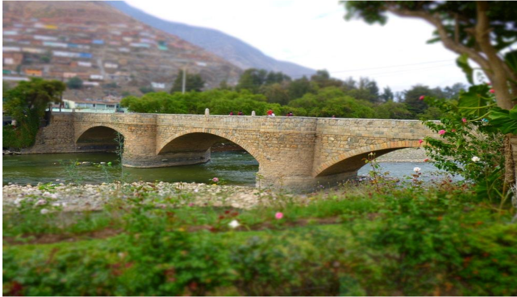
Figura N° 4.12: El puente Calicanto sobre el río Huallaga en la ciudad de Huánuco, presenta tres arcos escarzanos (rebajados). Podemos notar claramente el espesor de la bóveda de los arcos.
