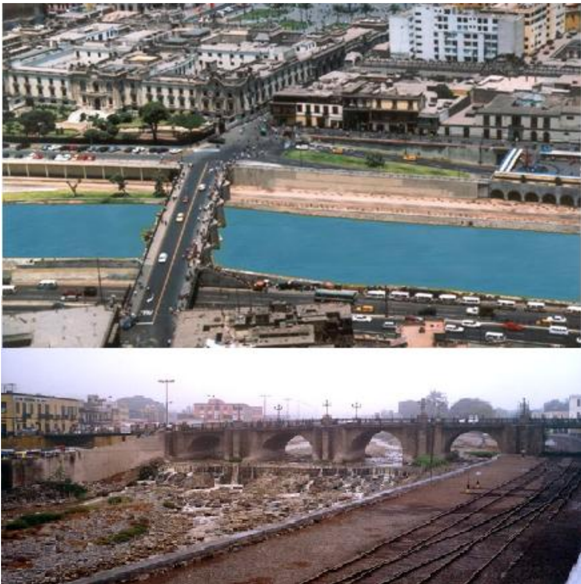
Figura N° 4.4: (Arriba) Vista panorámica del puente. (Abajo) Vista del puente desde la margen izquierda del río Rímac. En ambas vistas vemos aún el paso de vehículos menores.
