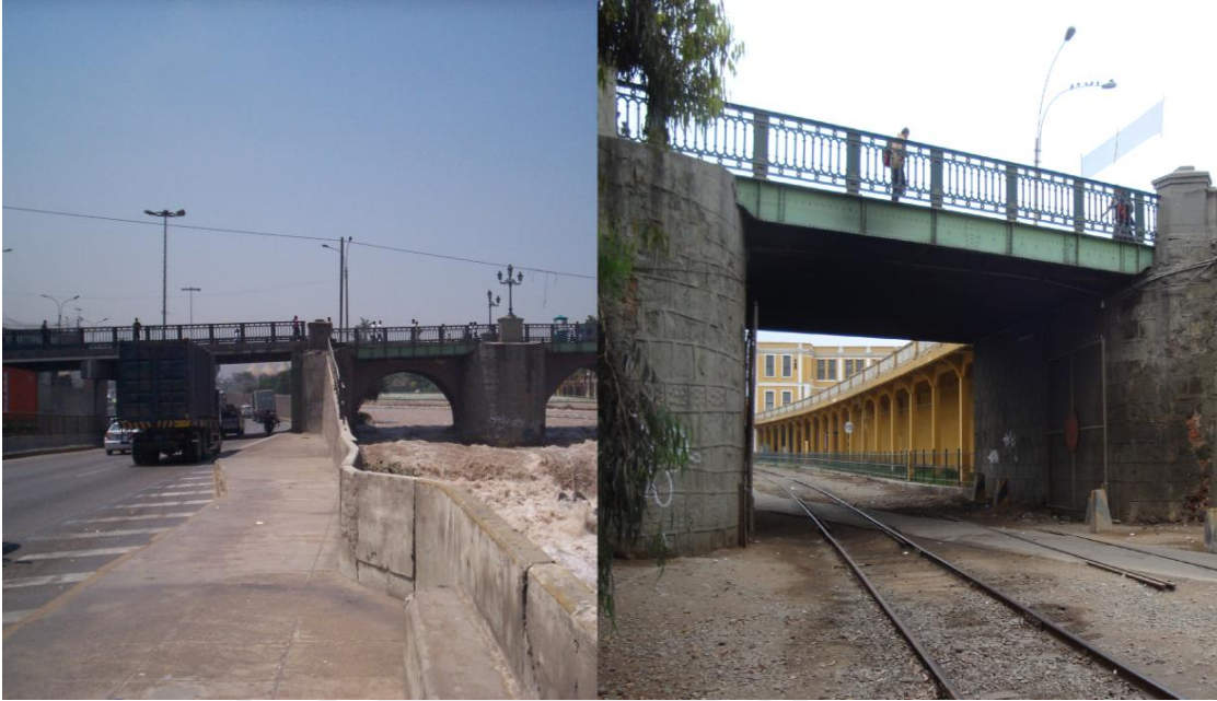
Figura 6.11: (Izq.) Se demolió el arco que estaba del lado del Rímac. (Der.) Igualmente se demolió el arco del lado del Centro de Lima.
