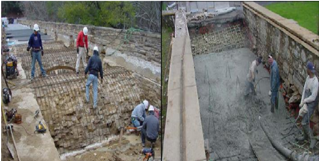
Figura N° 3.39: Ensanche con bóvedas de concreto encima de la bóveda original.
