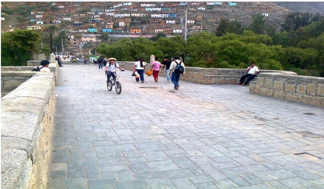
Figura N° 4.13: Observamos el paso peatonal de este puente, en un plan de restringir su paso vehicular, además notamos el pretil de piedra que conserva y sus amplios miradores circulares.
