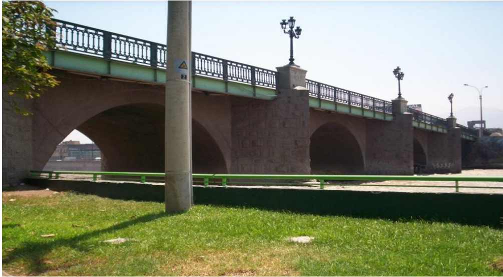
Figura N° 3.37: Puente ensanchado con vigas de perfil metálico.
