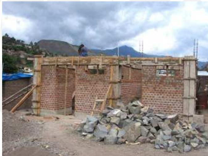
**Fig. 2.3 Armado de muros de fachada con columnas**
