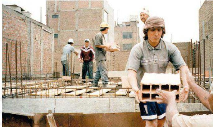
**Fig. 2.4 Preparado de la losa aligerada para su vaciado**
