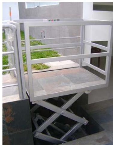
Figura 1.14: Plataforma hidráulica del tipo tijera
