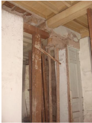
Foto 7: Apuntalamiento de Losa
