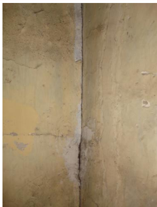
Foto 97: Grieta profunda en unión de muros.
