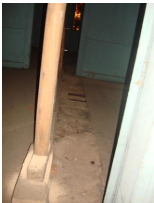
Foto 55: Sistema de entepiso sin entablado superior.
