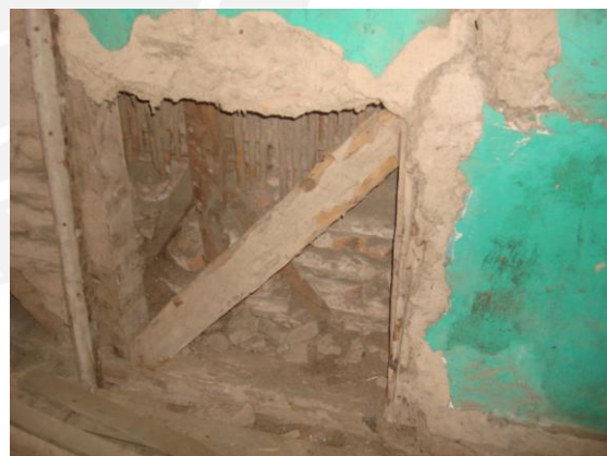
Foto 48: Tornapunta de muro de quincha expuesto al ambiente.
