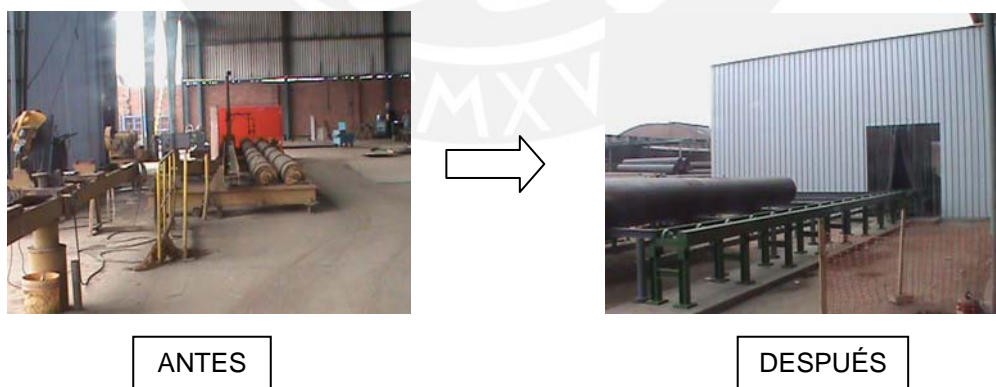
Figura 7. Puesto de trabajo corte de tubos por oxicorte
