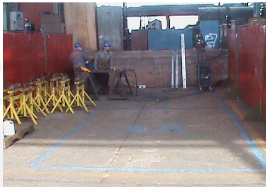
Figura 8. Áreas delimitadas en el puesto de armado de spools
