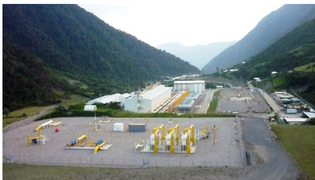
Ilustración 10 Estación de bombeo PS3
