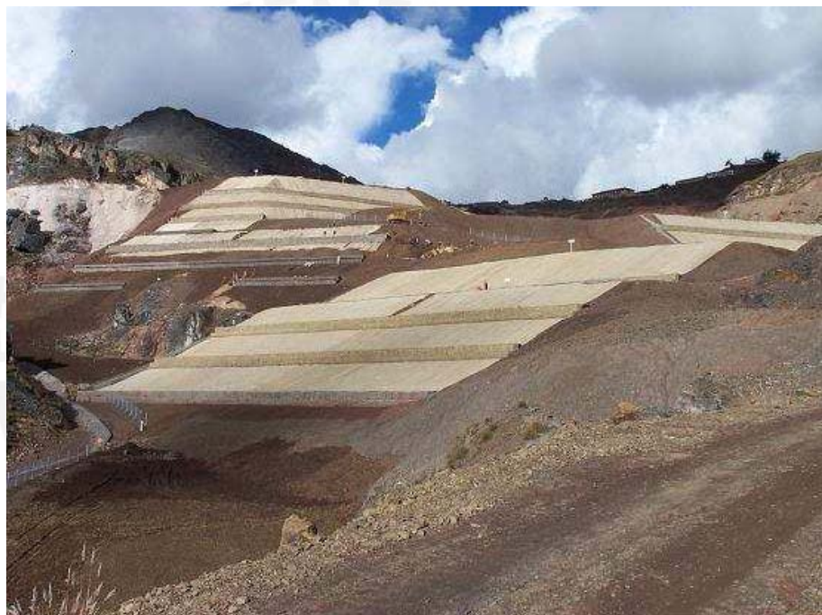
Figura No. 3.4.1 Rehabilitación de una escombrera reforzada con mantas de protección
