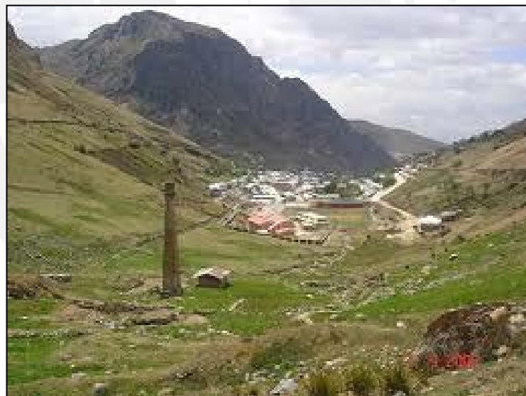
Figura No. 5.1.4 La chimenea de la fundición
