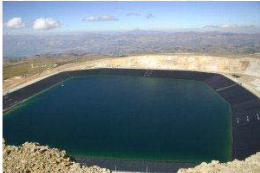
Figura No. 3.2.1 Tajo San José convertido en reservorio de agua
