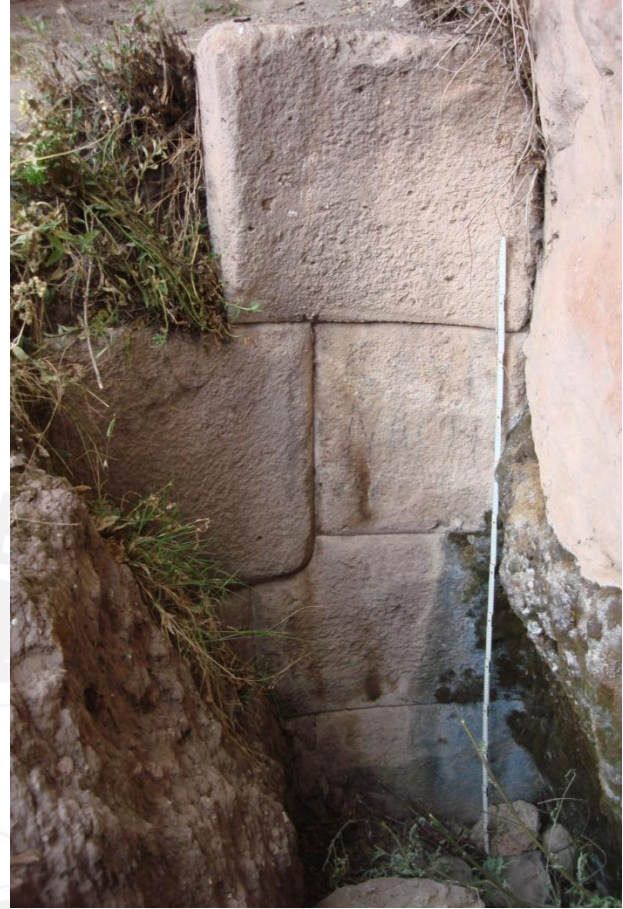
Ilustración 2.5: Fotografía de la fuente de agua construida con mampostería fina, hoy en desuso.
