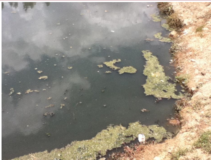
Foto 11. Mal estado de lagunas de oxidación en Sapallanga – Huancayo.
