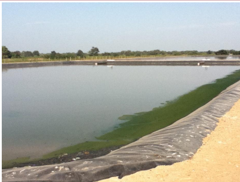
Foto 3. PTAR Pacora – Lambayeque (Laguna de Oxidación).
