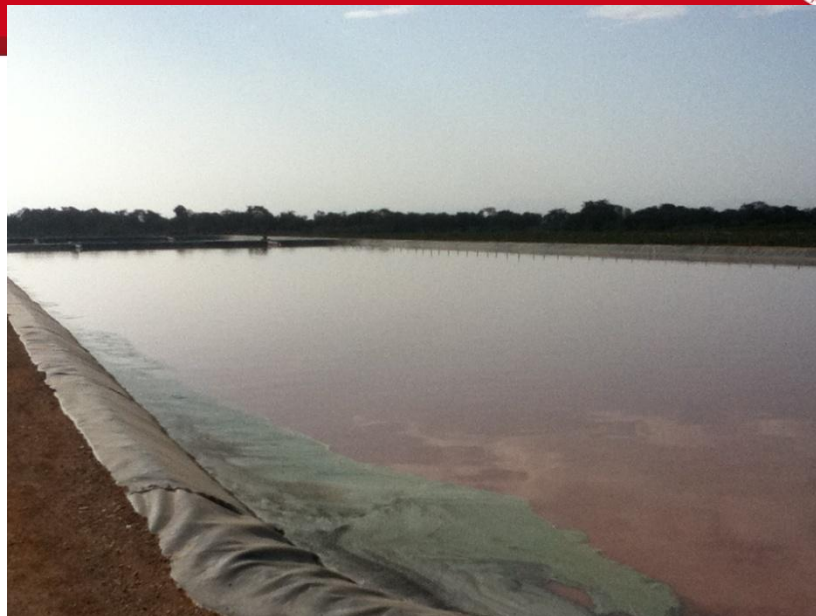
Foto 7. Agua mal tratada de la planta de tratamiento de aguas residuales Pacora – Lambayeque.
