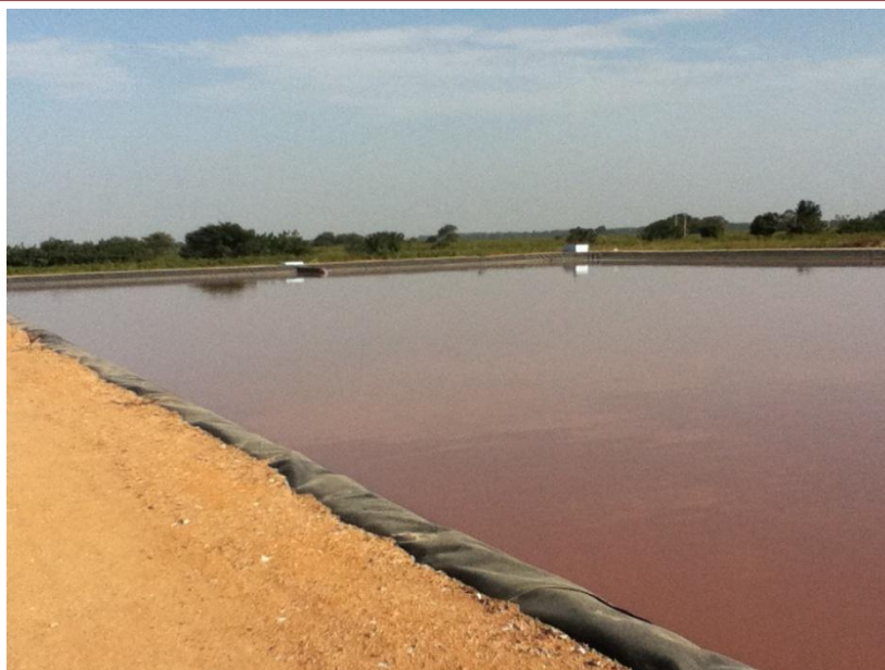
Foto 5. Laguna de oxidación de aguas residuales domésticas mezclada con sangre de los camales, Pacora – Lambayeque.
