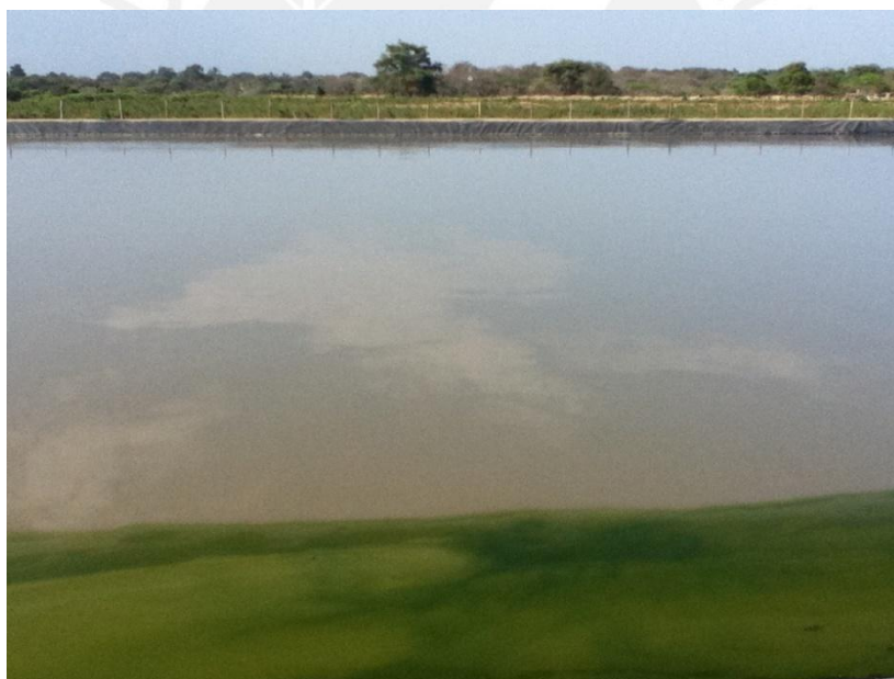
Foto 4. Laguna de oxidación en mal estado Pacora – Lambayeque.
