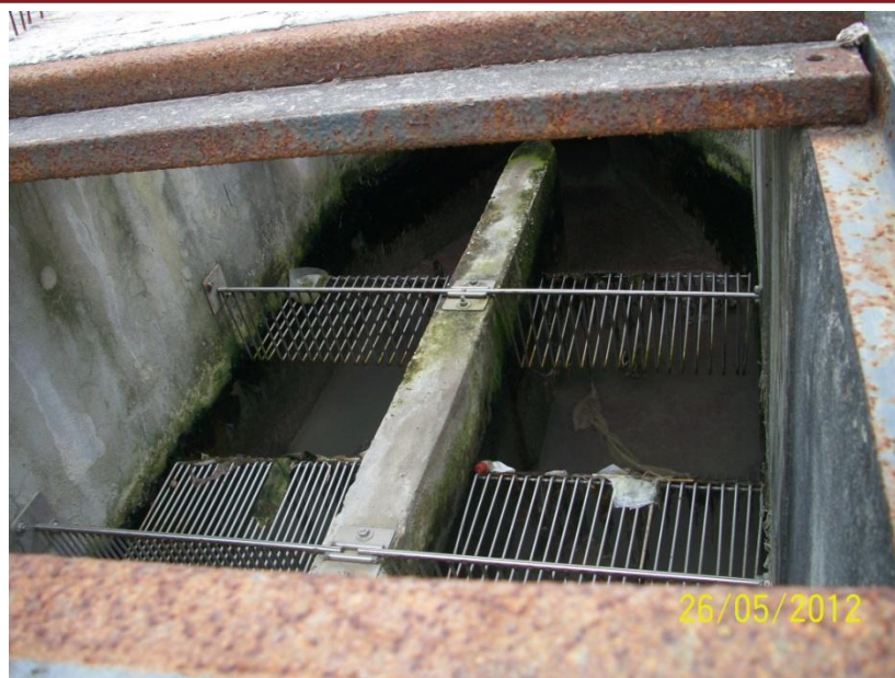
Foto 17. Cámara de rejas de PTAR SOTAS de Portal El Sol, Guayaquil – Ecuador.
