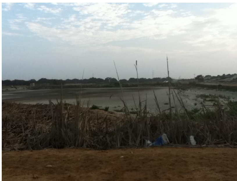
Foto 1. Planta de tratamiento de aguas residuales (Laguna de oxidación) en mal estado en Lambayeque.
