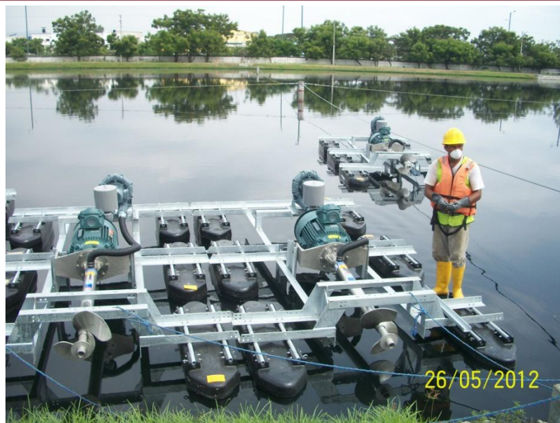
Foto 25. PTAR Guayaquil con problema de olores solucionados con aireadores.
