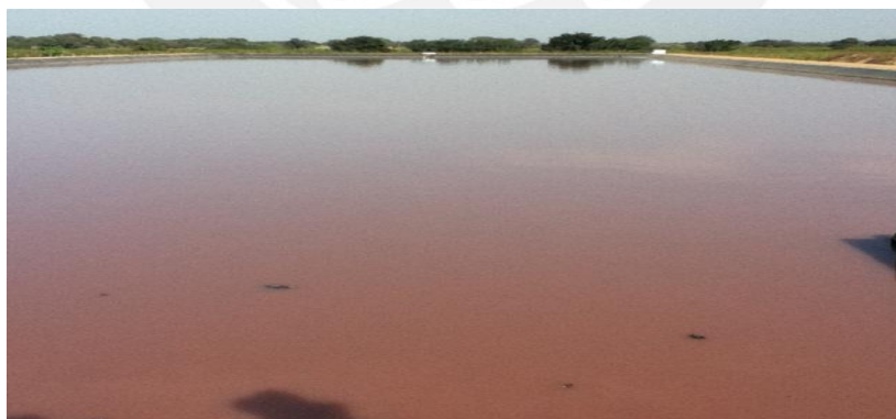
Foto 2. Nueva PTAR (Laguna de oxidación) en Lambayeque, ampliación de laguna en mal estado.
