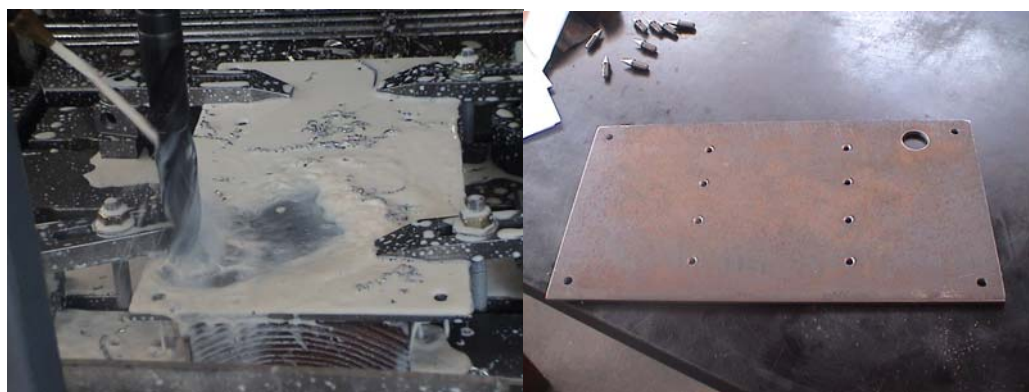
Figura 3.54 Fabricación de la placa base.
