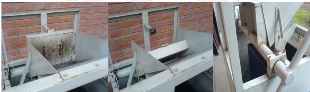
Figura 3.59 Imágenes del sistema de compactado.
