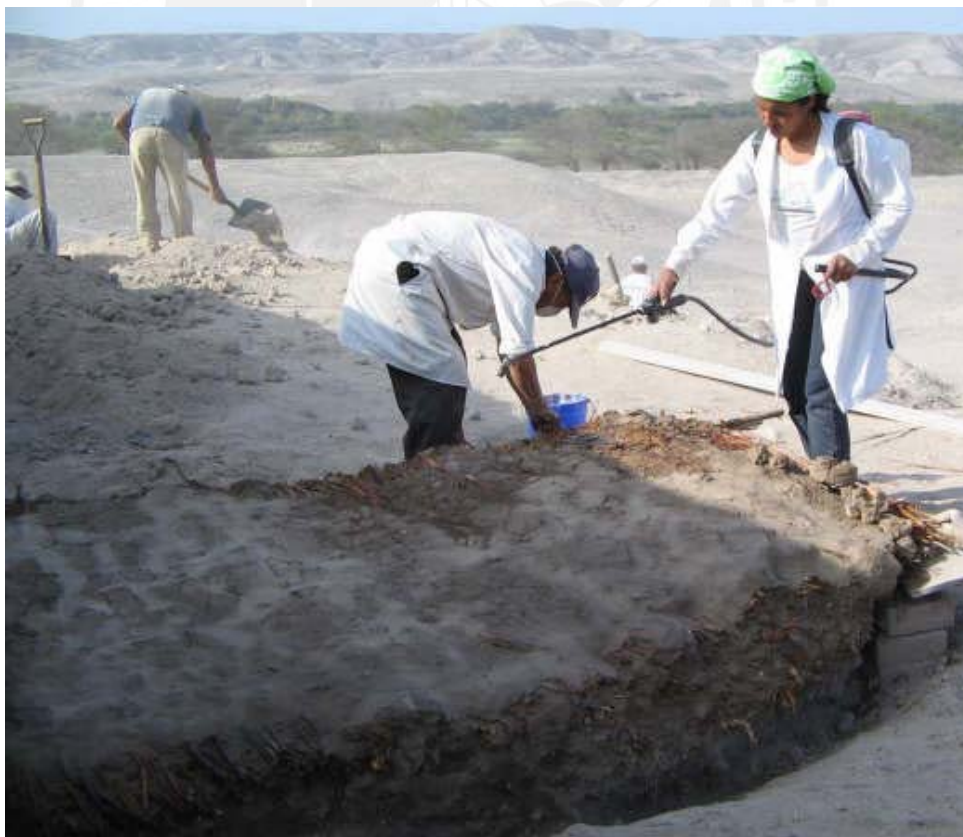
Fig.28g: Consolidación del muro de quincha con restos de enlucido. Foto: Vanessa Tinteroff.
