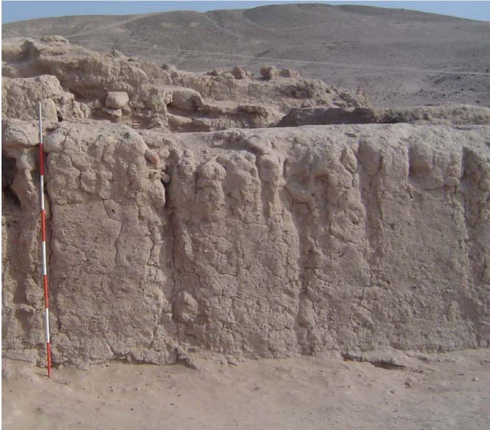
Fig. 60a: Muro 1 o Muro Sur de la Plaza, construido durante la Tercera Fase. Resalta el acceso sellado y el material constructivo agregado en la cabecera del muro (en una fase posterior) para otorgarle mayor altura. Vista Norte.
