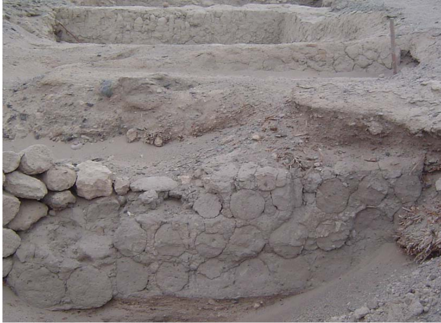
Fig. 15b: Muro de adobes cónicos, Tercera Plataforma de la Gran Pirámide, vista Norte.
