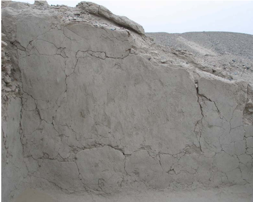
Fig.37a: Restos de muro de Tercera Fase con enlucido perfectamente alisado y hallado en regular estado de conservación. Quinta Plataforma de la Gran Pirámide, Vista Oeste. Foto: Ángel Sánchez.
