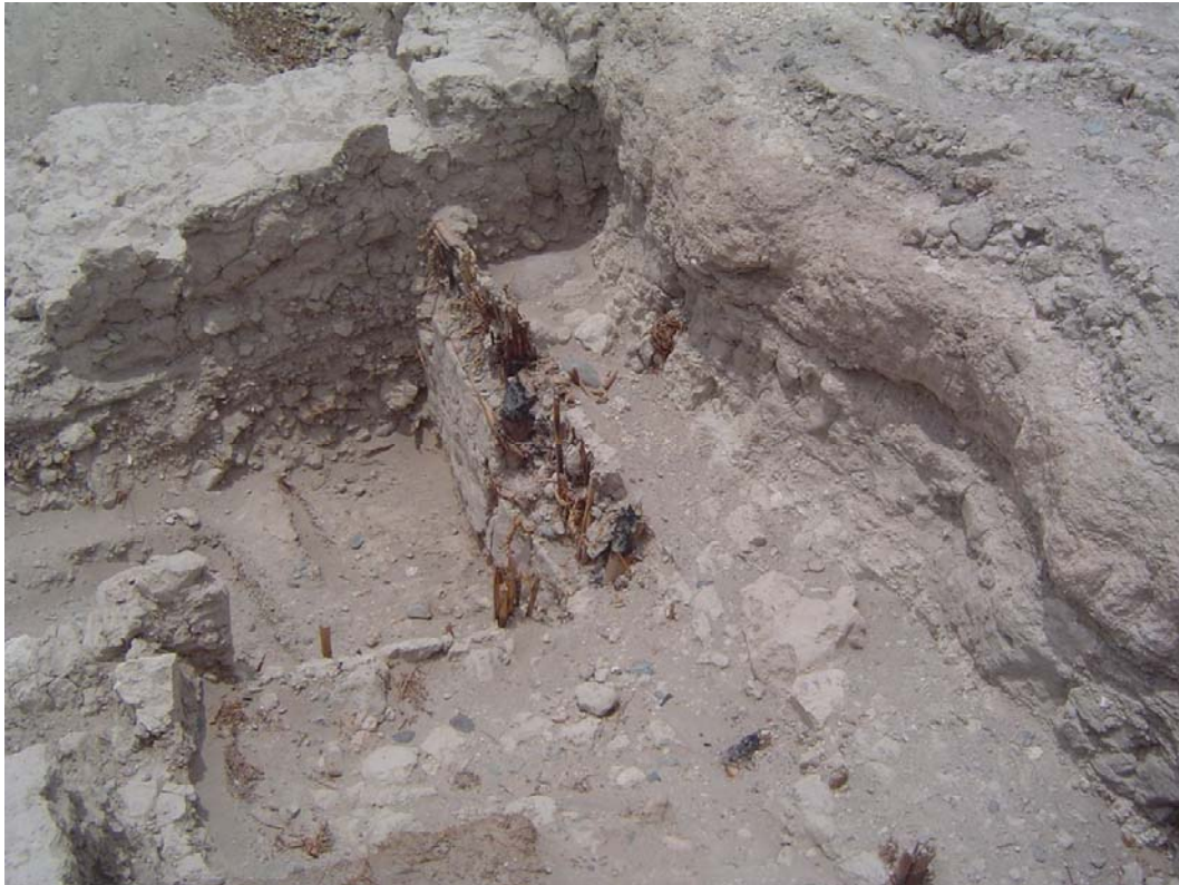
Fig.28b: Vista Noroeste de muro de quincha.
