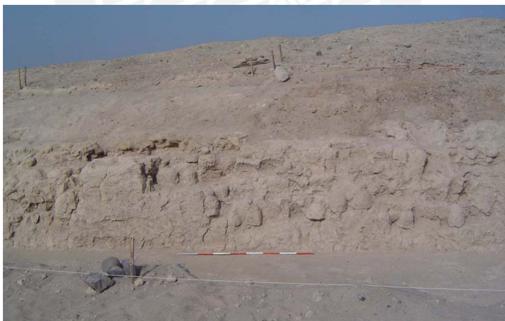
Fig. 61b: Parte del Muro 2 o Muro Este de la Plaza donde la erosión ha sido más intensiva, exponiendo los adobes que lo conformaron. Nótese que en su cabecera resalta el material constructivo adicional que fue colocado en un momento posterior a su construcción. Vista Este.
