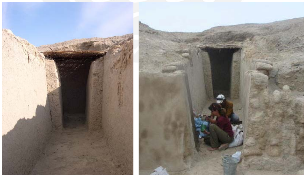
Fig.35e: Acceso principal en el Frontis de la Gran Pirámide que consiste en un estrecho pasadizo. Tercera Fase Constructiva, Vista Norte. Fotos: Ángel Sánchez.
