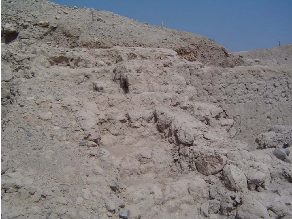
Fig.80b: Vista de la escalera construida en el muro de contención de la Plataforma Oeste. Vista Oeste.
