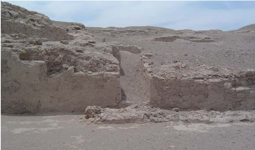
Fig.23: Acceso en forma de rampa construido en el muro Sur de un espacio abierto ubicado en el Montículo 1. Vista Norte.
