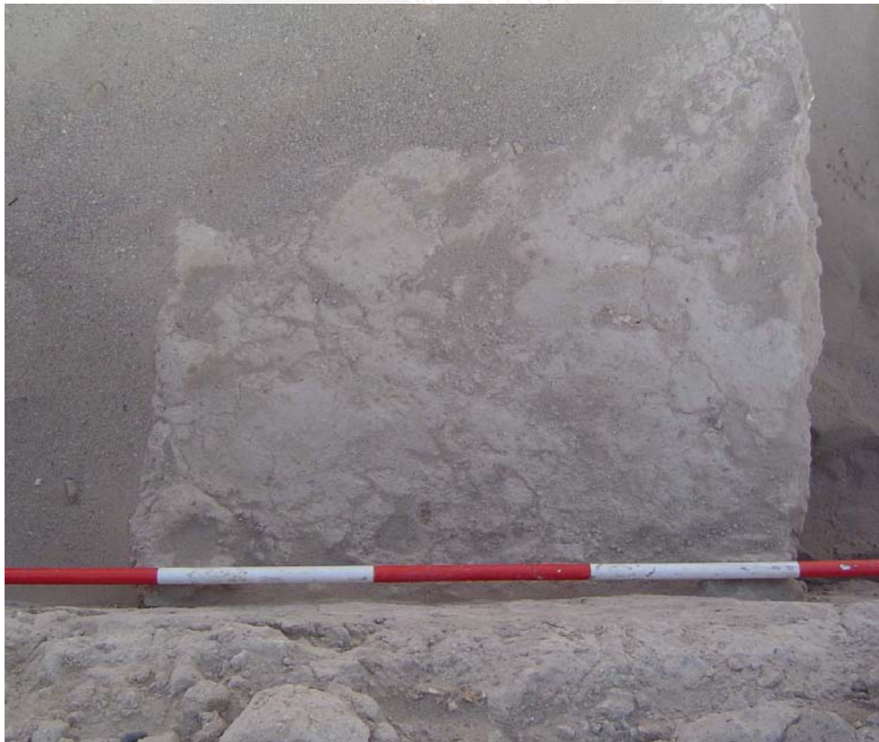
Fig.56b: Vista de planta del Muro 9, mostrando su grosor total.
