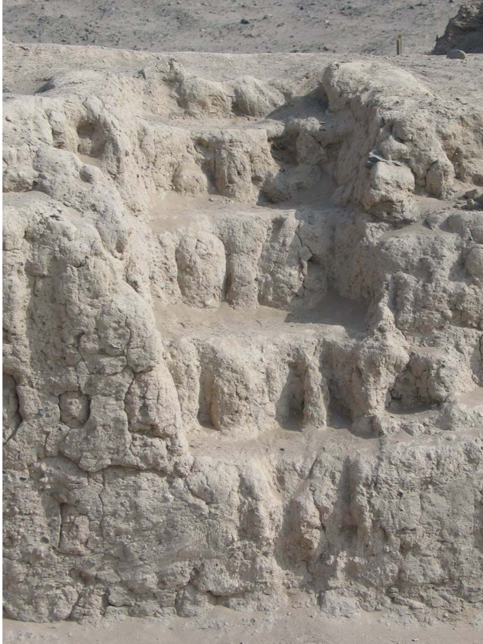
Fig. 60c: Detalle de la escalera construida en el Muro 1. Fue hallada en regular estado de conservación (exponiendo los adobes que la conformaron) y resaltó por los angostos de su ancho (40 – 50 cm. de ancho aproximadamente). Vista Norte. Foto: Maria Gasior.
