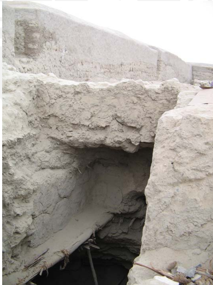
Fig. 15c: Estructura de adobes paniformes y molariformes (Tercera Fase Constructiva) construida sobre un murete de adobes cónicos (Segunda Fase). Foto: Liz Gonzáles.
