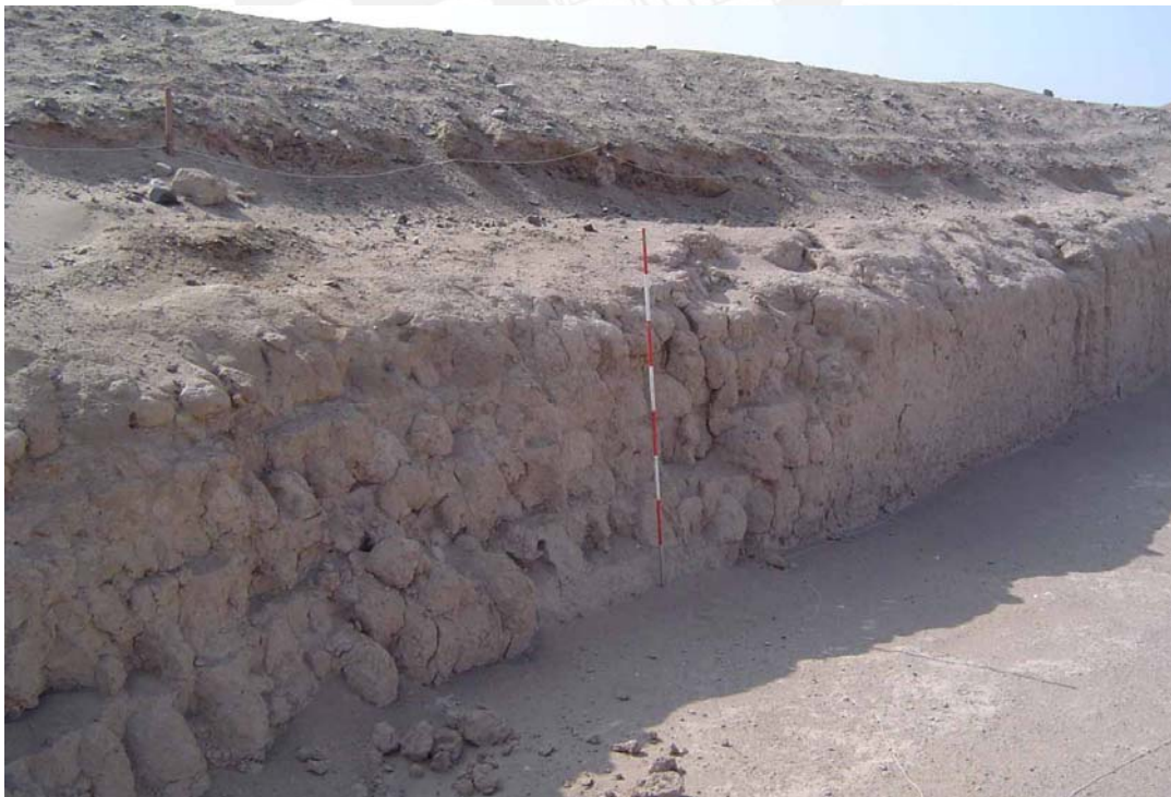
Fig. 61d: Vista Sureste del Muro Este de la Plaza.
