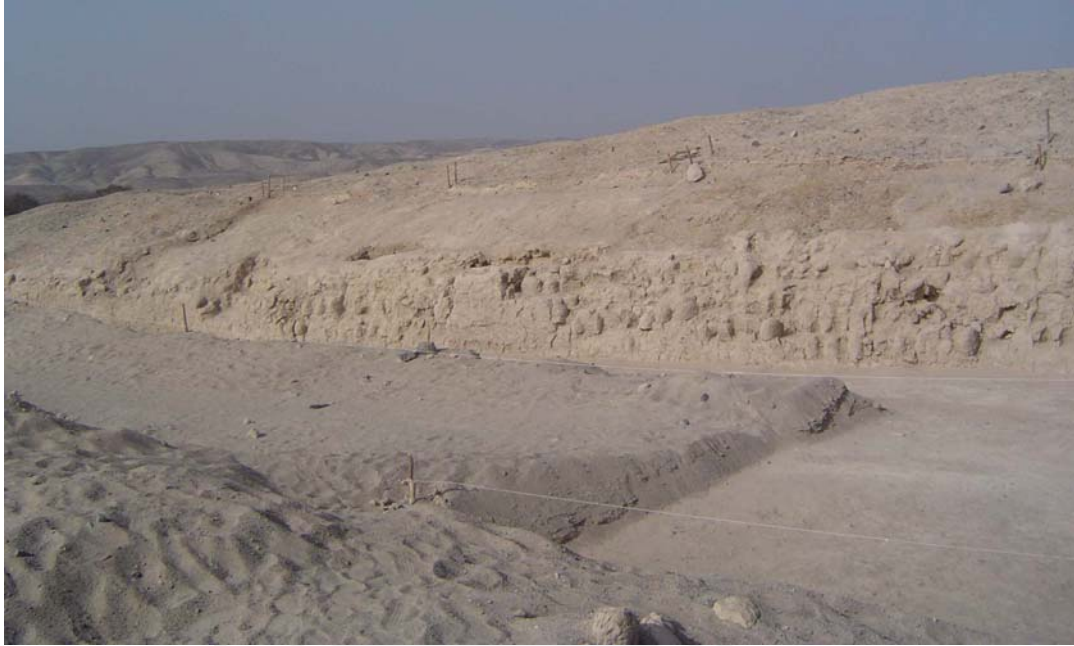
Fig. 61c: Muro 2 o Muro Este de la Plaza. Vista Noreste.
