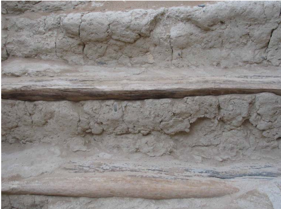
Fig. 19b: Detalle de los restos del enlucido bajo los fragmentos de madera de algarrobo colocados en la parte exterior de los peldaños. Foto: María Gasior.
