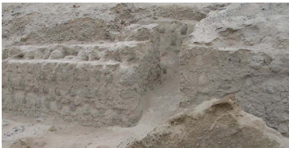
Fig.35b: Acceso con pasadizo en forma de L que conduce al interior de una estructura de la Segunda Plataforma de la Gran Pirámide, Tercera Fase Constructiva. Vista Noreste. Foto: Maria Gasior.
