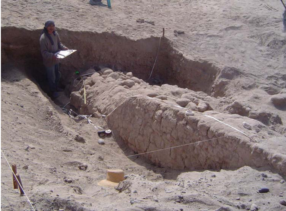
Fig.42: Vista del muro Oeste de la Plaza al Este de la Gran Pirámide, cuya causa de colapso puede atribuirse a movimientos sísmicos. Sus restos fueron dejados in situ por los Nasca, siendo cubiertos íntegramente por material de relleno para la construcción de una nueva estructura. Vista Sur.
