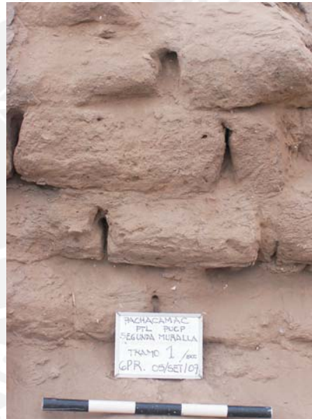
Foto No. 106 Cara Sur Muro E Foto G. Presbítero
