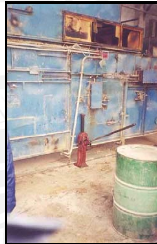
Izaje del secador con las gatas de uñas.
