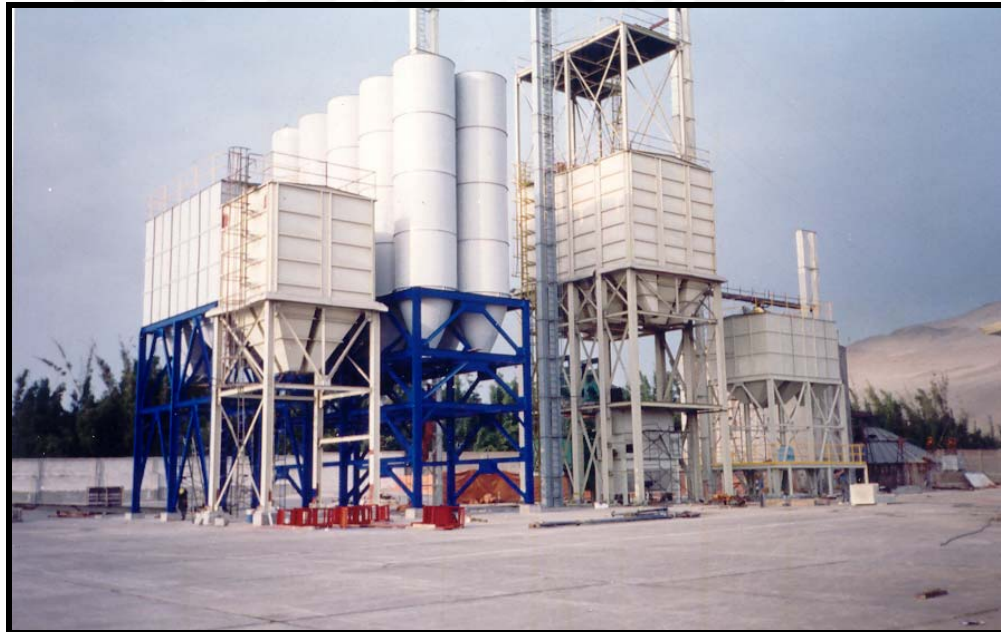
Figura 1.12: Tolvas de una planta de AABB, de derecha a izquierda: pre-molienda, pre-pelet, producto terminado circulares, producto terminado rectangulares.
