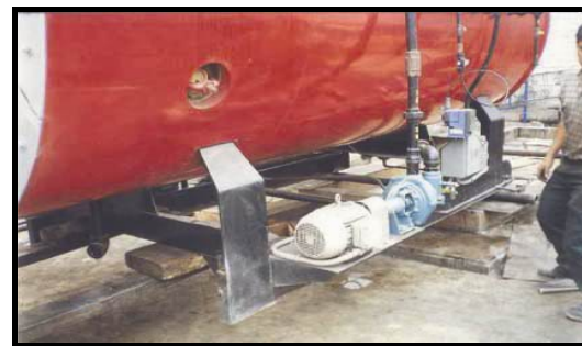
Gatas con uñas levantan el caldero para colocar polines (tubos)
