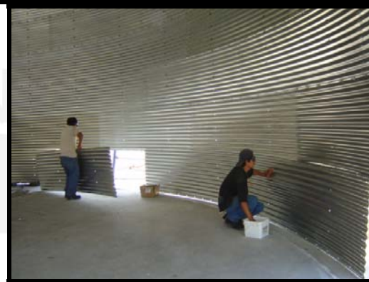
Figura 3.8.- Secuencia del armado de silos en la parte interior.
