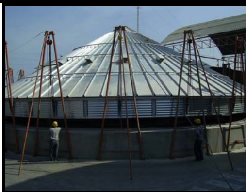
Figura 3.7.- Disposición de trípodes para montaje de silo fondo plano.
