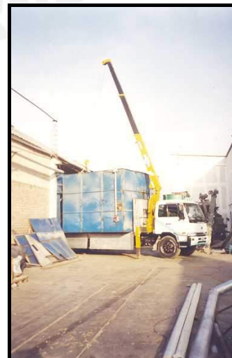
Acomodo de parte superior en camión, se usa la pluma de la grúa
