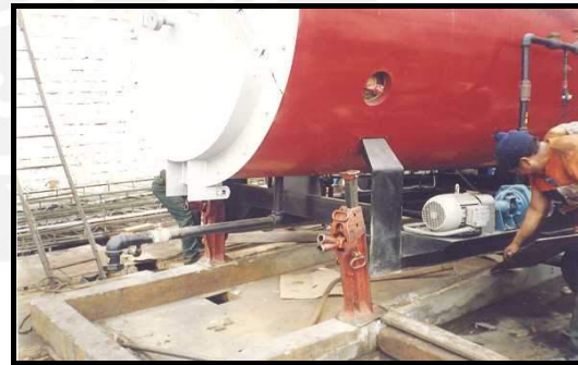
Gatas con uñas levantan el caldero para colocar polines (tubos)
