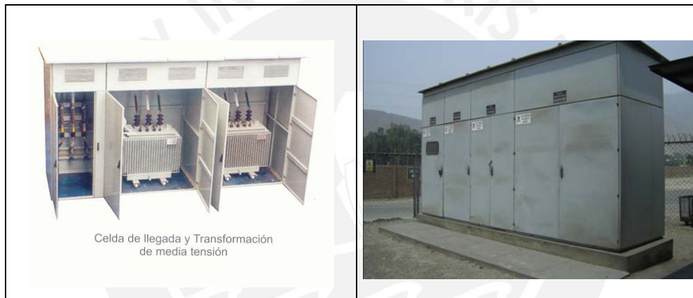
Figura 4.4.- Celdas de transformación y llegada
