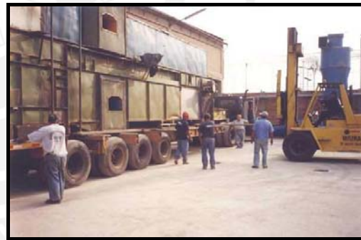
Descarga con dos montacargas de 10 ton.
