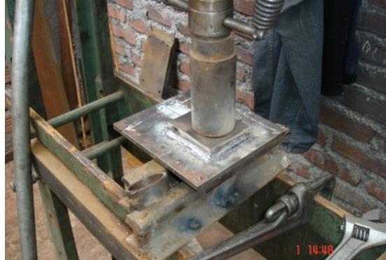
SOLDADO DE PLANCHAS PARA BASE DEL TENSADOR.
