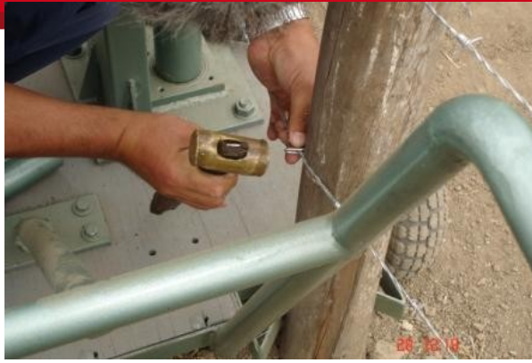
FIJACIÓN DEL ALAMBRE AL POSTE DE MADERA.
