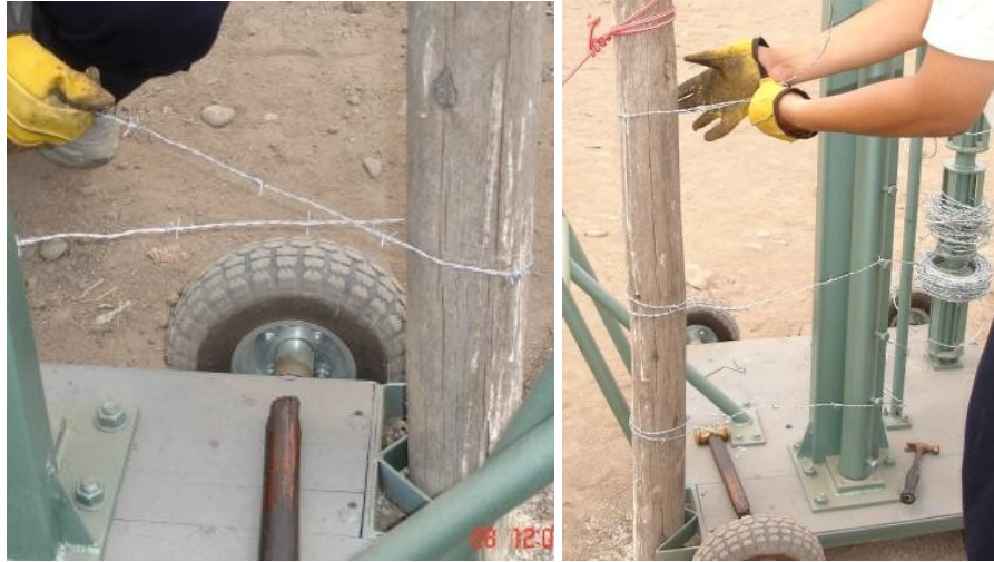
FIJACIÓN DE LOS ALAMBRES AL PRIMER POSTE.
