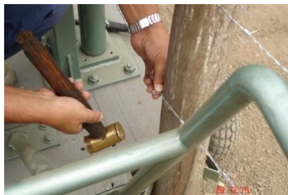
FIJACIÓN DE LOS ALAMBRES A LOS POSTES.
