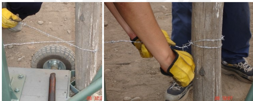
FIJACIÓN DEL ALAMBRE AL PRIMER POSTE.
