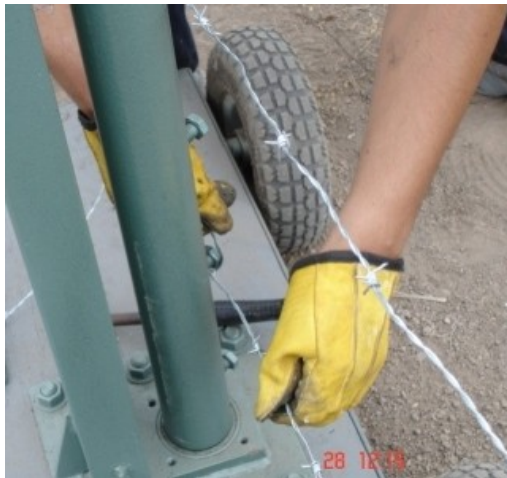
FIJACIÓN DEL EQUIPO A LOS GANCHOS DEL TENSADOR.
