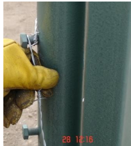
FIJACIÓN DEL EQUIPO A LOS GANCHOS DEL TENSADOR.
