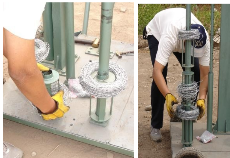
COLOCACIÓN DE ROLLOS DE ALAMBRE EN EL EQUIPO.
