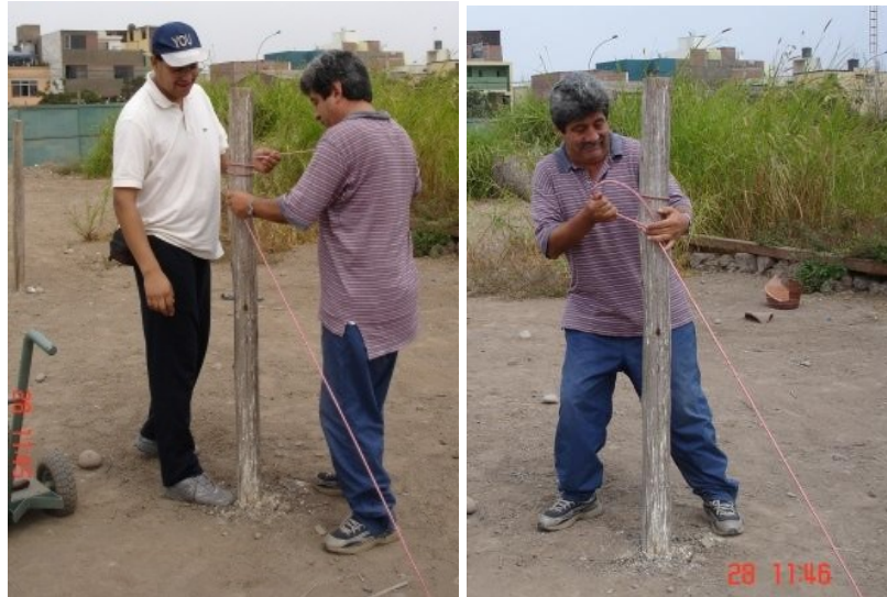
TEMPLADO DEL PRIMER POSTE PARA EVITAR SU FLEXIÓN.
