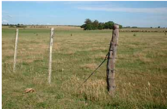
Alambrado de 6 hilos en línea recta, el largo total de la línea es de aproximadamente 800 m.
