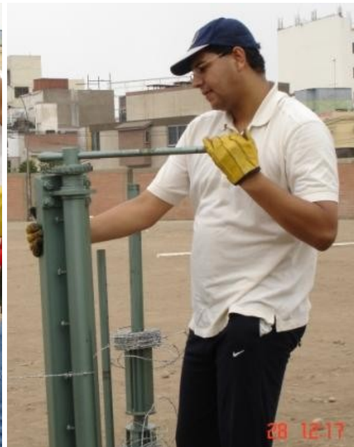
TENSADO DE LOS ALAMBRES.
