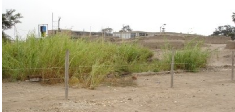
ALAMBRADO INSTALADO EN LA PUCP.
