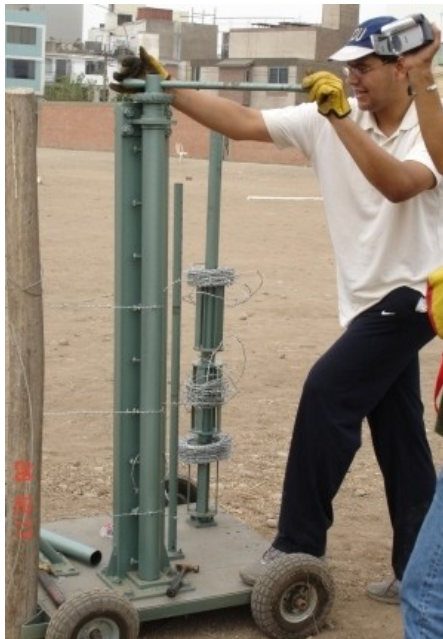
TENSADO DE LOS ALAMBRES.
