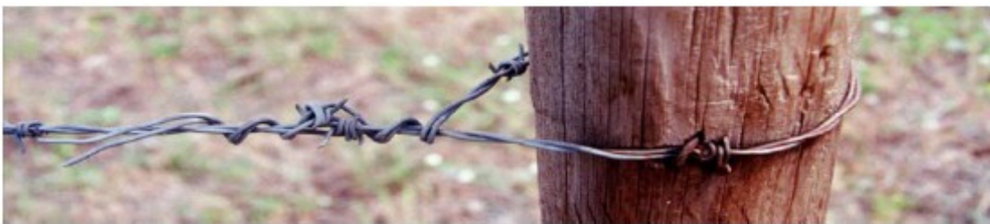
FIJACION DEL ALAMBRE AL PRIMER POSTE
