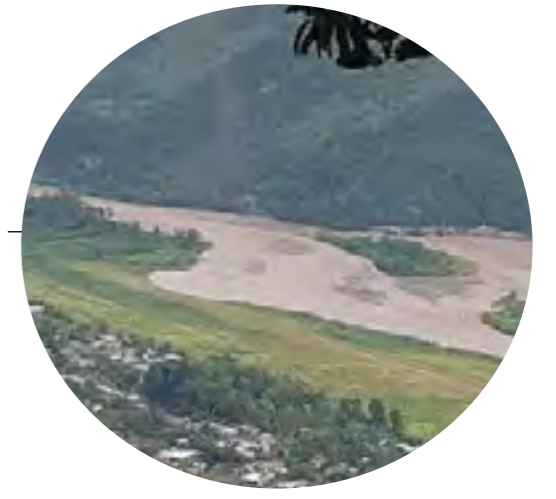
4 Zona erosionada en la parte trasera del Aeropuerto
