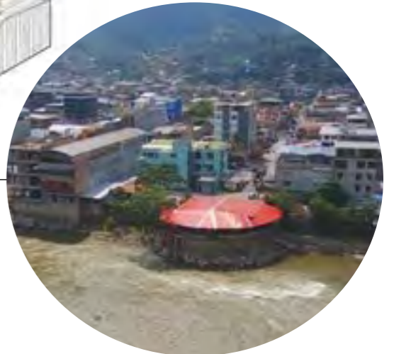
5 Viviendas en margen derecho con muro de protección
