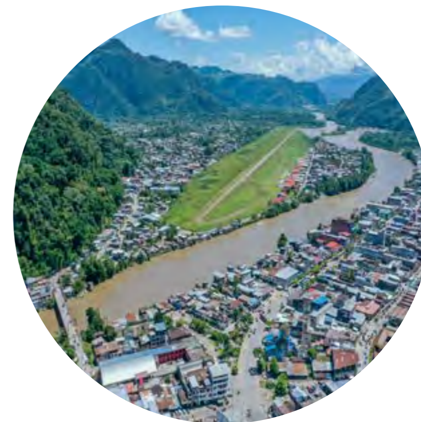
Tingo María 2021 Aeropuerto erosionado por el río Huallaga
