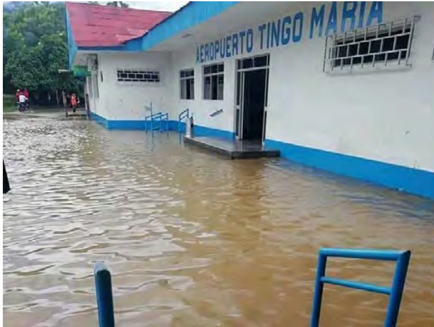
Desborde del río Huallaga llega a la instalación y entrada principal del Aeropuerto
