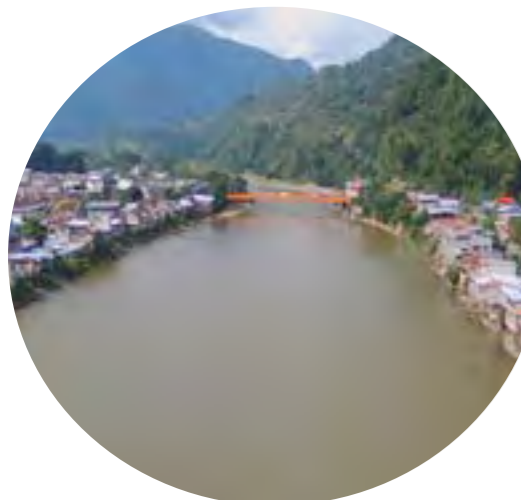
3 Puente Córpac: única conexión actual existente entre ambos márgenes del río Huallaga
