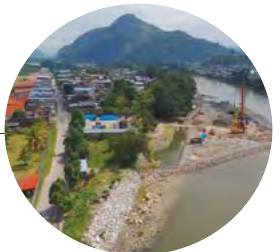
3 Inicio de nuevo puente en construcción que conecta en eje hacia la Plaza de Armas de la ciudad
