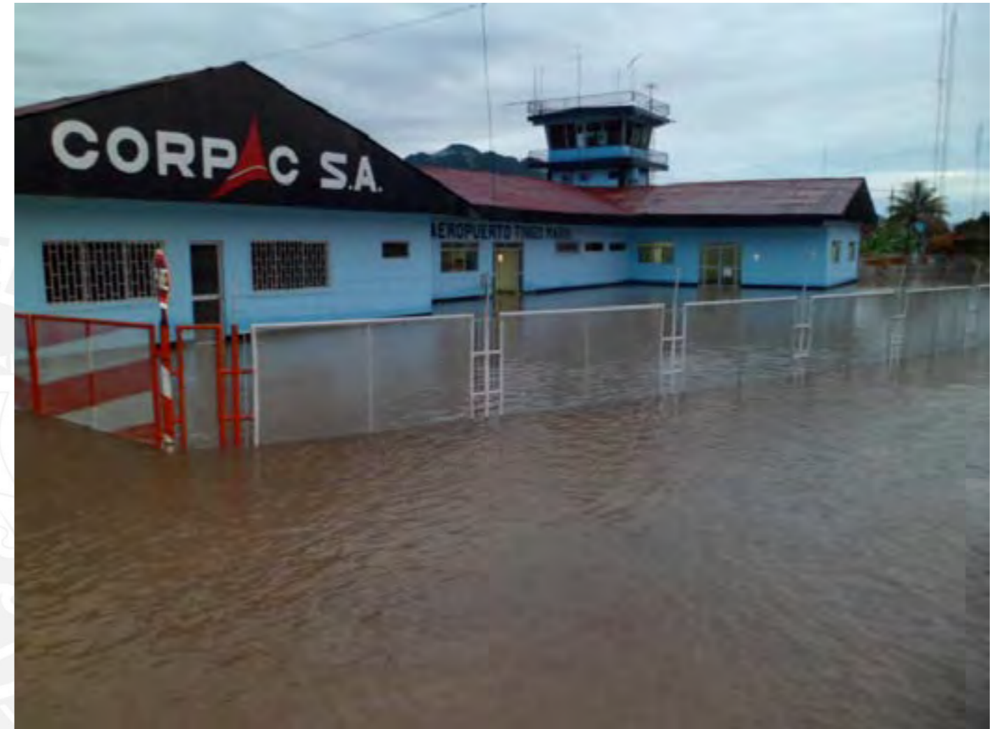
Nivel de inundación sobrepasa losa de instalación y entrada principal del Aeropuerto de Tingo María
