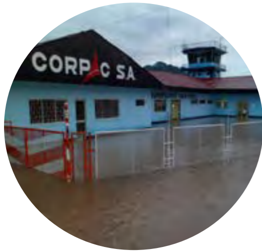
1 Inundación en instalación principal Aeropuerto de Tingo María
