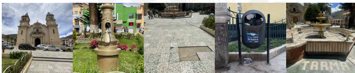
Figura 68. Problemas hallados en la Plaza de Armas de Tarma. Elaboración propia.
