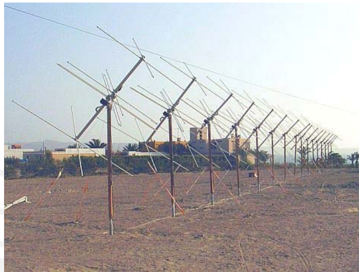
Figura 3-7 Arreglo de antenas tipo Yagi en Paracas
