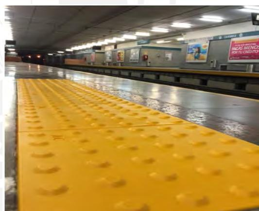
Figura 4: Guía podo- táctil de botones de caucho flexible
