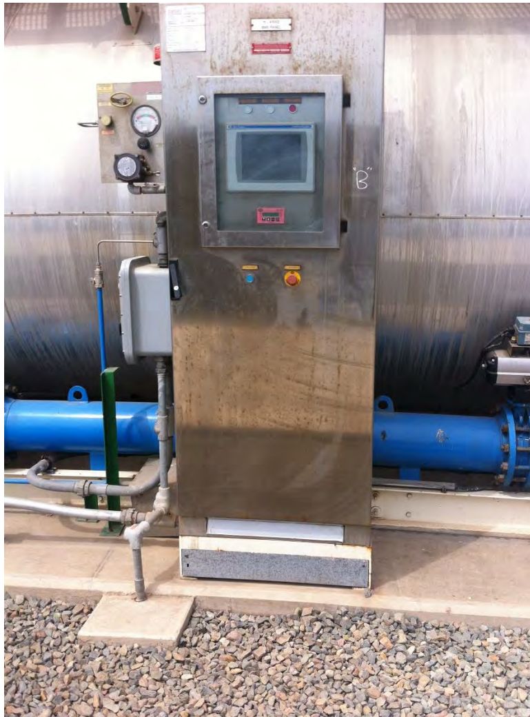
Figura 5.5 RTU del calentador B, a un costado del calentador de la planta de estudio
