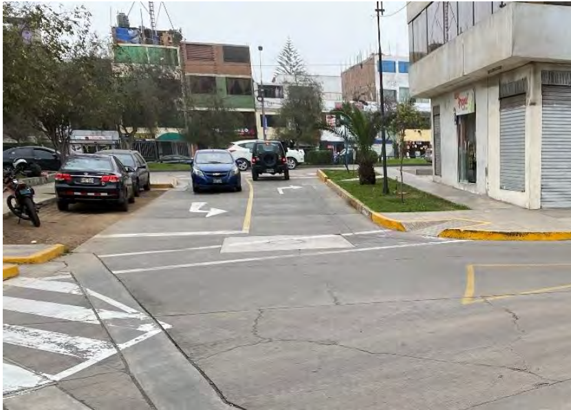
Figura 6.3: Senda de cruce peatonal incorrecta
