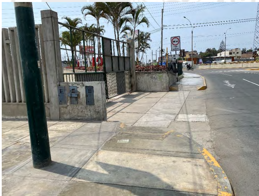
Figura 6.16: Rampas del punto C
