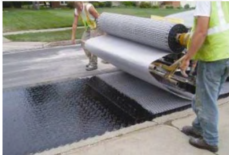
Figura 1.3: Instalación de geosintéticos en pavimentos (Baamonde et al., 2011).
