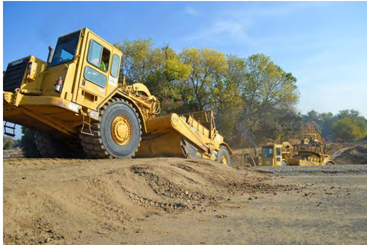
Figura 1.2: Reemplazo de suelo blando con el uso de una mototrailla (Yepes, 2021).
