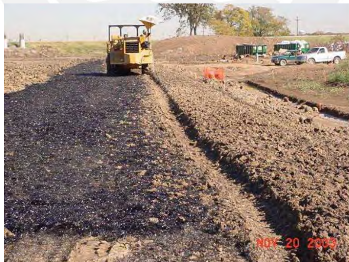
Figura 1.5: Reforzamiento del terraplén con fibras de polipropileno en la autopista President George Bush Turnpike (Gregory G. , 2006).
