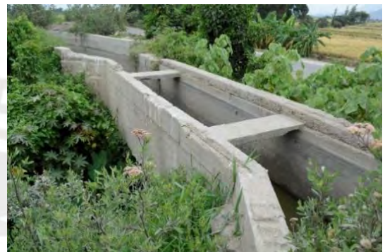
Canal de cemento
