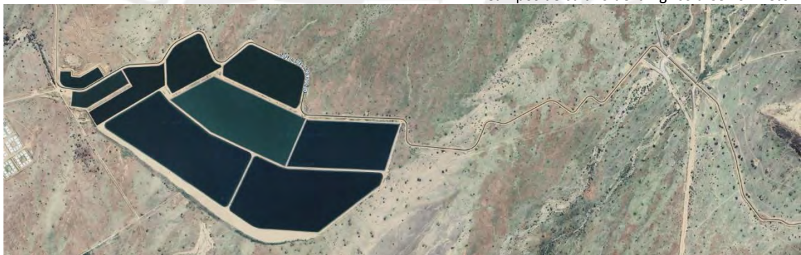
Vista detallada del ingreso del agua por canales a los fundos de agroexportación.
