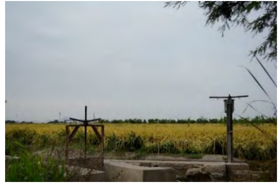
Compuerta en la confluencia de dos acequias
