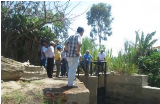
Agricultores observan la compuerta
