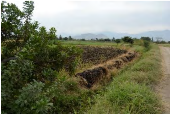
Acequia sin revestimiento de cemento
