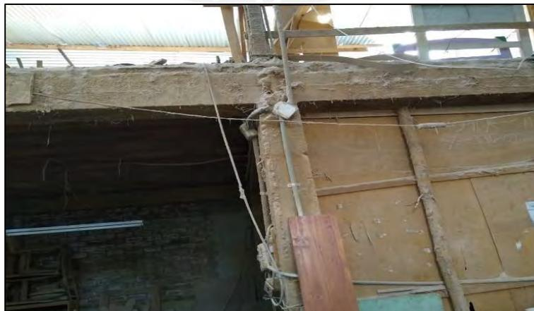
*Figura 23.* Conexiones eléctricas sueltas y en mal estado.
